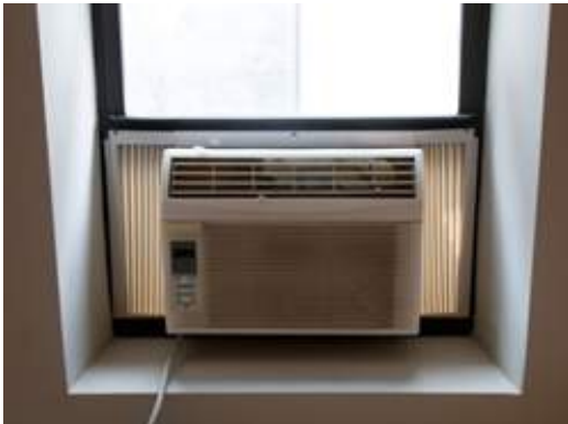
Figuras 3 e 4 – Aparelhos de Ar Condicionado de janela.
