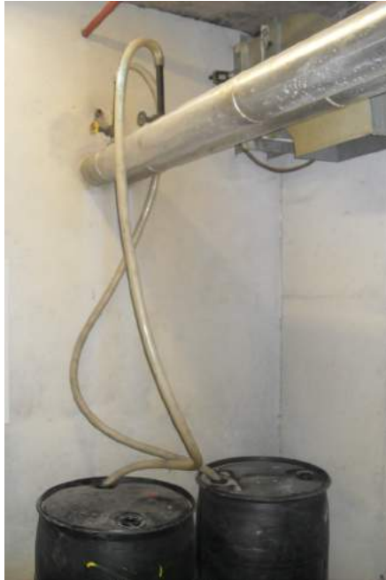
Figura 38 – Sistema de Purga de Ar Manual Improvisada.
