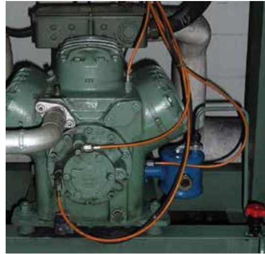
Imagem 42: Exemplo de uma instalação adequada usando mangueiras flexíveis termoplásticas.
