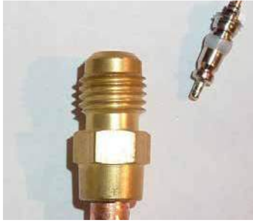
Imagem 35: Corpo da válvula Schrader com núcleo.
