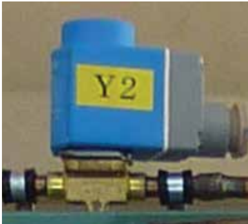
Imagem 7: Fixação adequada da válvula solenoide por cliques para tubos corretamente posicionados.
