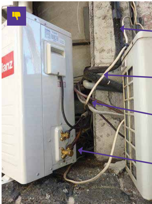
Imagem 73: Exemplo de instalação inadequada de tubos de transferência de fluido refrigerante, isolamento e cabeamento.
