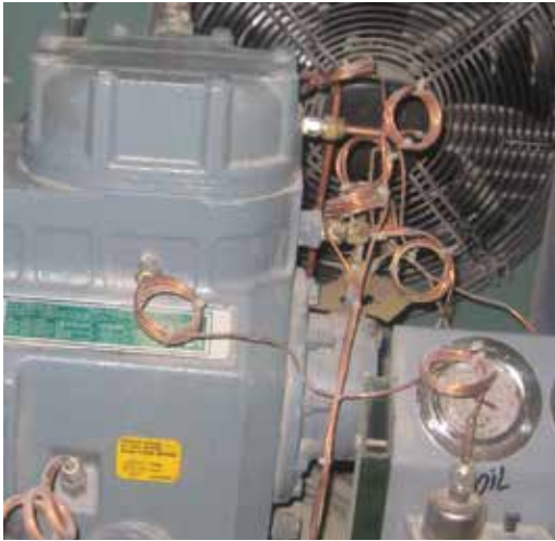
Imagem 41: Exemplo de uma instalação inadequada de tubo de cobre (capilares).
