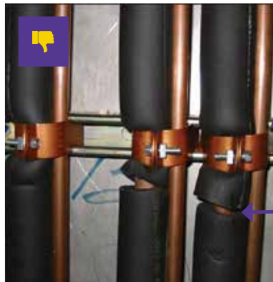
Imagem 74: Exemplo de instalação inadequada de tubos de transferência de fluido refrigerante e isolamento.
