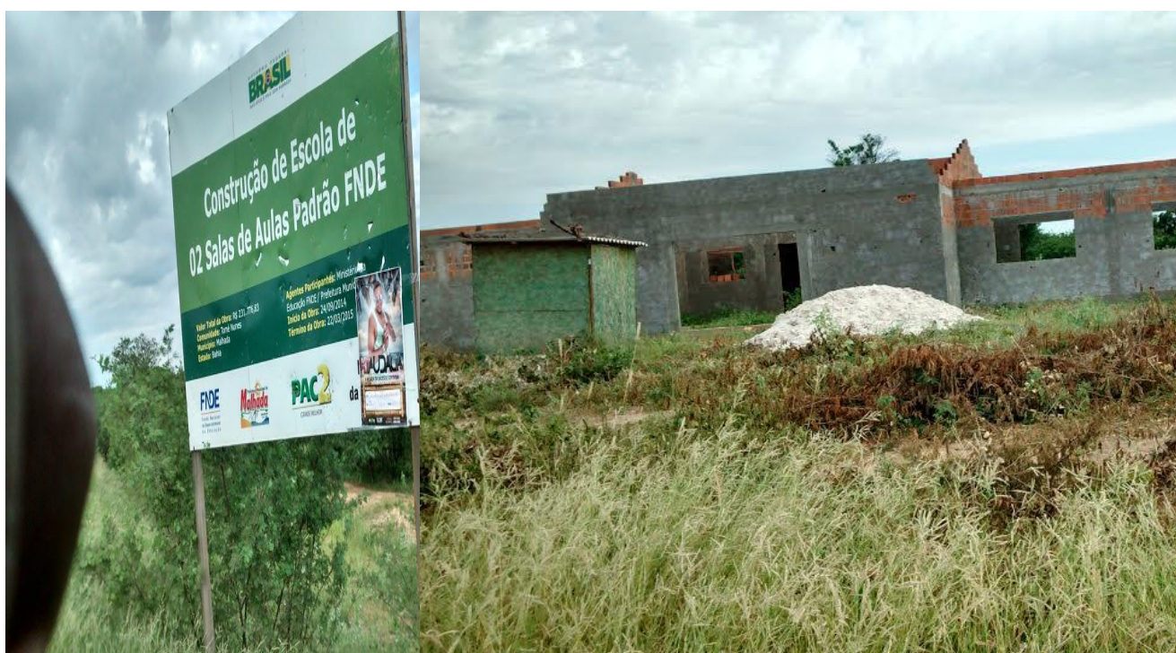
Figura 9: Placa do governo Federal. Escola em construção.
