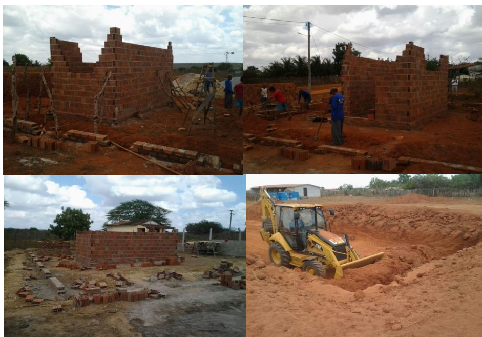
Figuras 22 a 25 – Obras civis dos sistemas de dessalinização em Açucena, Maria da Paz, Limão e Bom Sucesso.
