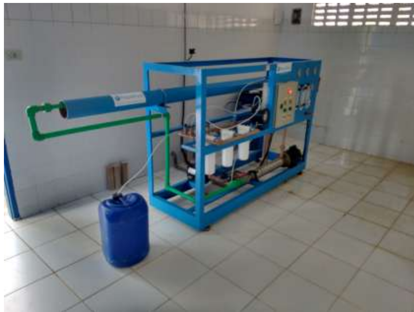
Figura 32. Equipamento de dessalinização da comunidade Gravatá.
