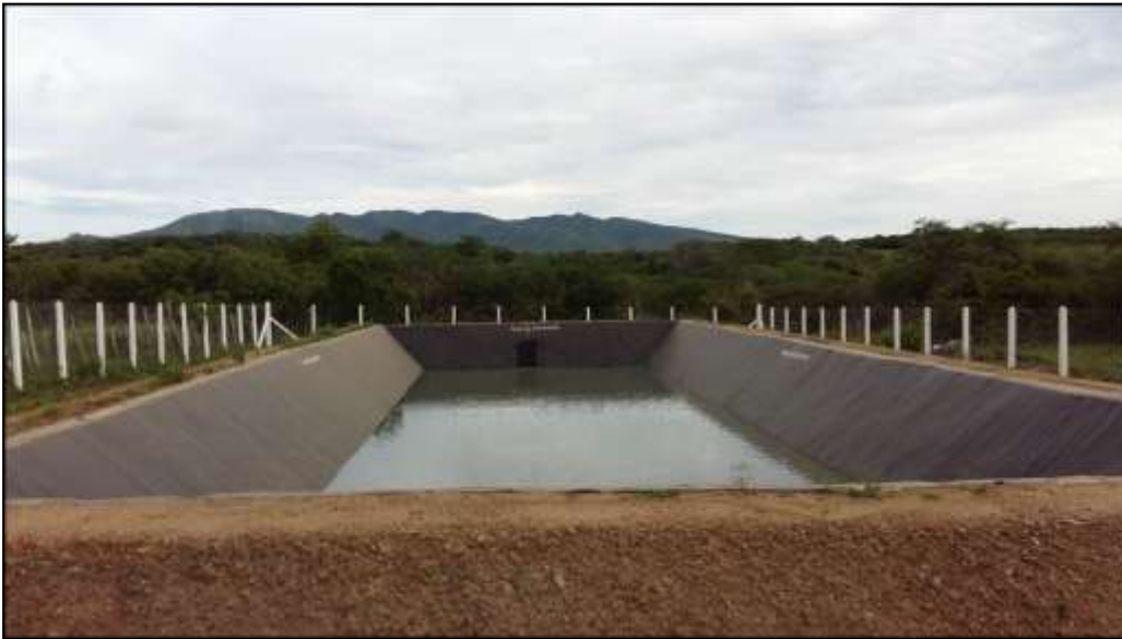
Figura 21 – Tanque de armazenamento do concentrado
