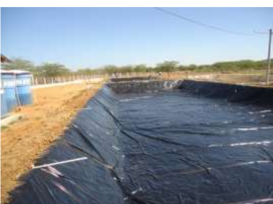
Figura 13, 14, 15, 16, 17, 18, 19 e 20 –Processo de implantação da lona pvc
