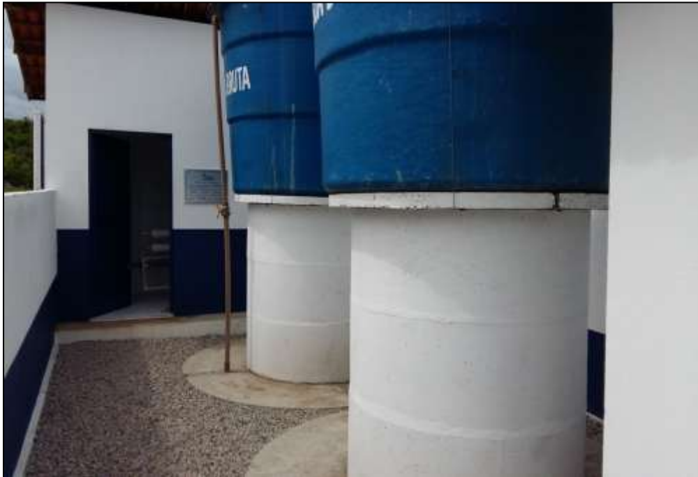
Figura 11 – Bases dos reservatórios – pré-moldado
