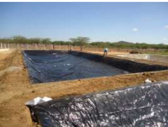
Figura 13, 14, 15, 16, 17, 18, 19 e 20 –Processo de implantação da lona pvc
