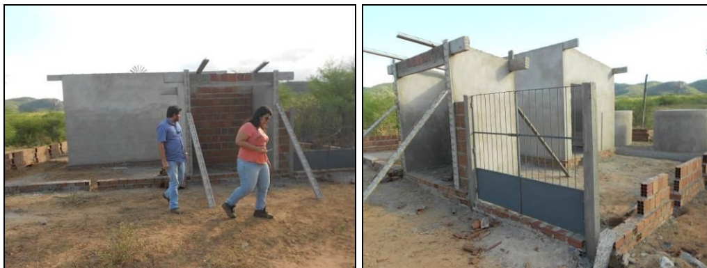
FIGURA 17. Sistema em Construção.
