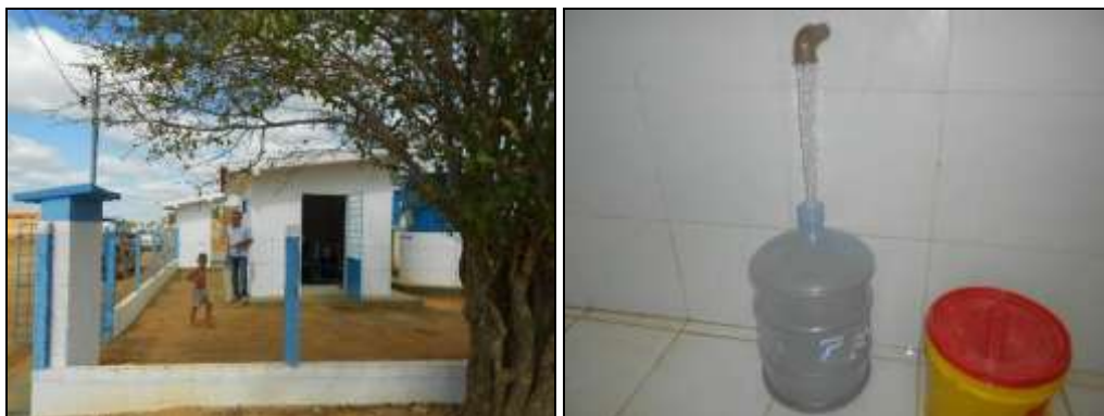
FIGURA 48, 49. Sistema de Dessalinização e Água potável no Chafariz.
