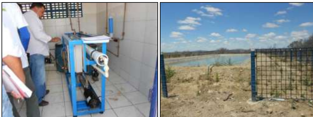
FIGURA 39, 40. Dessalinizador e Tanque do Concentrado.
