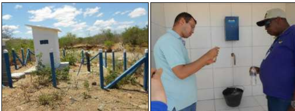
FIGURA 41, 42. Proteção do poço tubular e análise da água no Chafariz.
