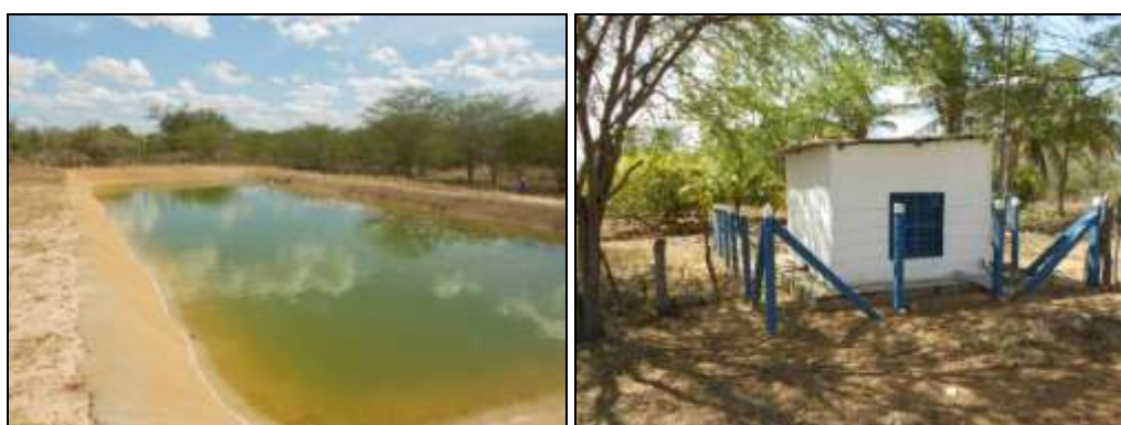
FIGURA 63, 64. Tanque do Concentrado e Proteção do poço.
