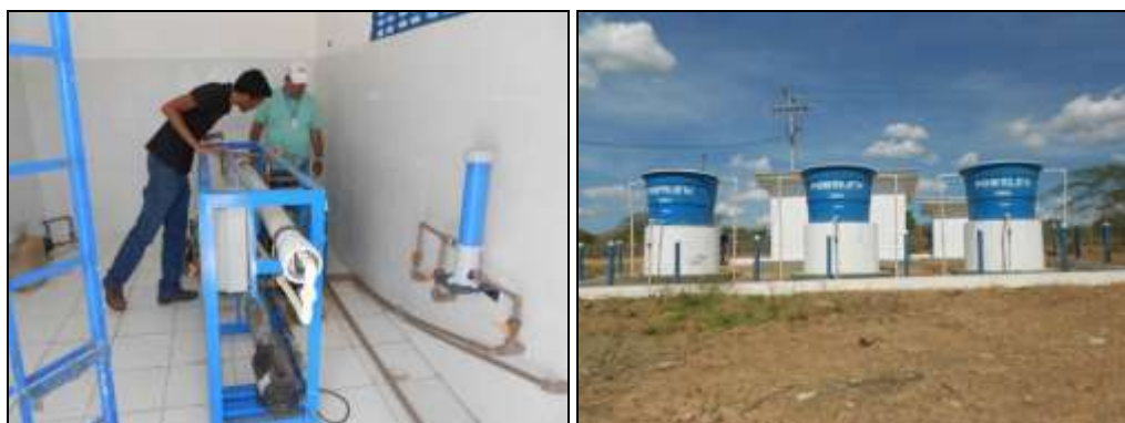
FIGURA 61, 62. Dessalinizador e bases dos reservatórios.
