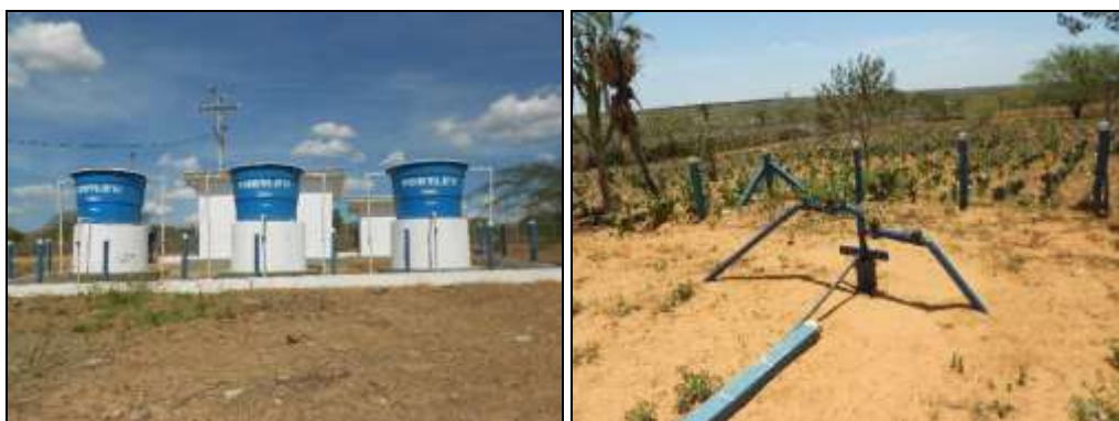
FIGURA 56, 57. Bases dos Reservatórios e Proteção do poço.
