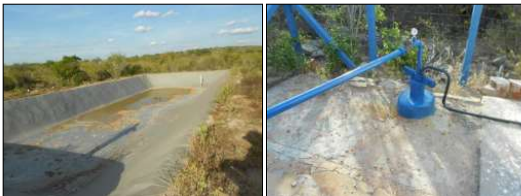
FIGURA 70, 71. Tanque do Concentrado e Poço da comunidade.
