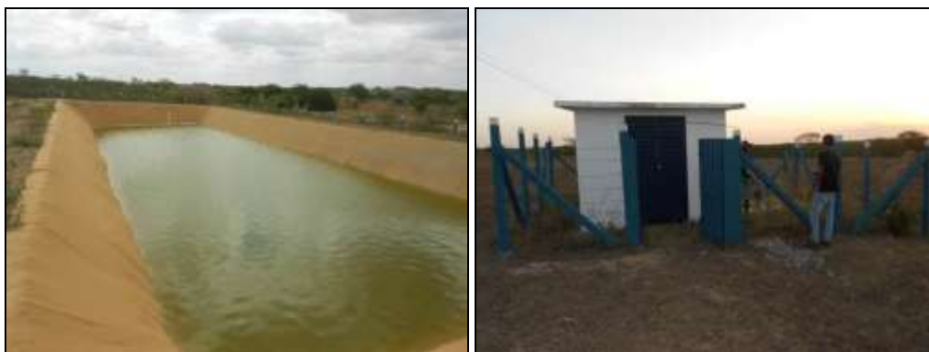
FIGURA 54, 55. Tanque do Concentrado e cercamento do poço.
