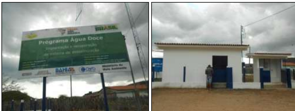
FIGURA 22, 23. Placa da obra e sistema de dessalinização.
