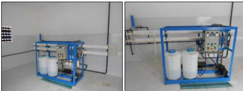
FIGURA 24, 25. Dessalinizador funcionando.
