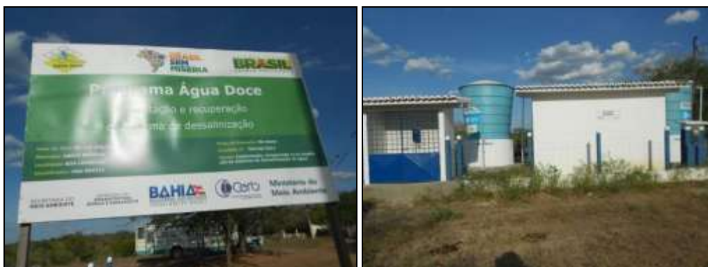
FIGURA 66, 67. Sistema de Dessalinização.
