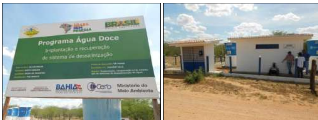
FIGURA 59, 60. Sistema de Dessalinização.
