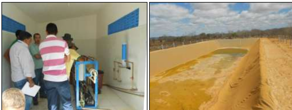
FIGURA 46, 47. Dessalinizador e tanque do Concentrado.
