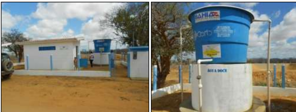
FIGURA 44, 45. Sistema de Dessalinização.
