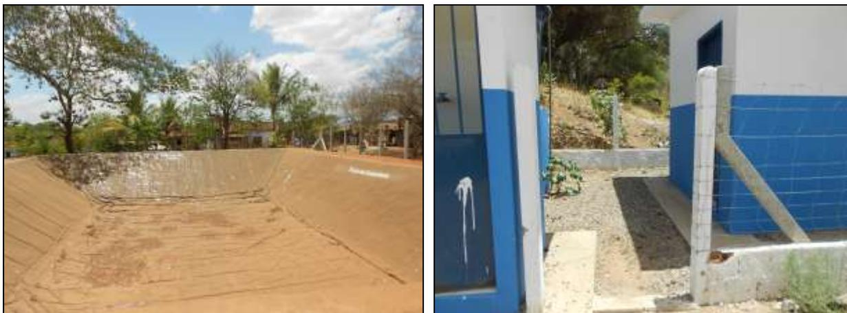
FIGURA – 105, 106 Tanque do Concentrado e abrigo do dessalinizador.
