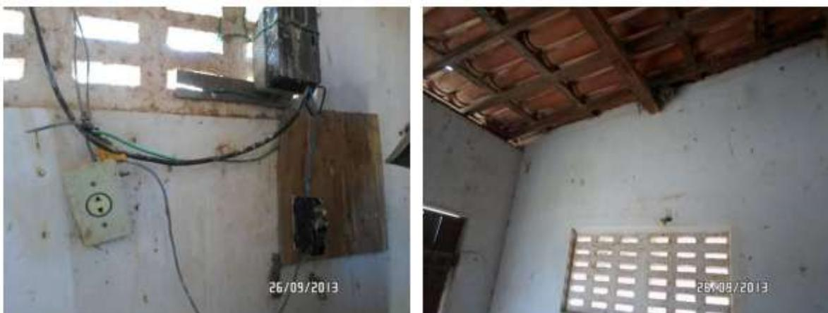
FIGURA – 62, 63 Abrigo do dessalinizador em estado de degradação.
