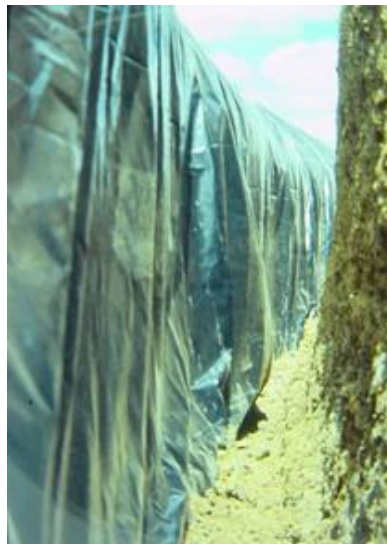
Foto 17. Visualização da valeta após a colocação da manta plástica.
