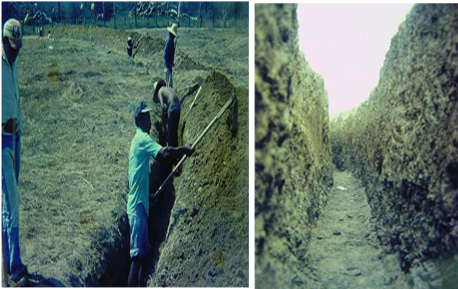
Foto 16. Visualização dos detalhes da valeta para a colocação da manta plástica
