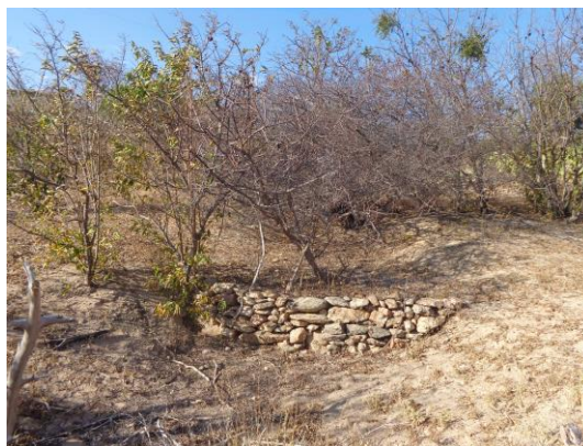
Figura 6 - Mureta de pedra para controle de erosão Foto: João Macêdo Moreira
