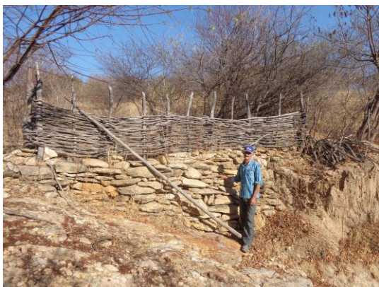
Figura 5 - Barramento de pedra na voçoroca Foto: João Macêdo Moreira
