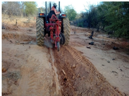
Figura 1: Construção dos cordões de terra em curva de nível.
