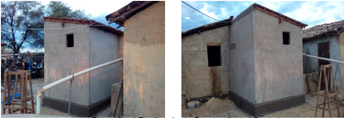
Figura 3 e 4 Finalização da Construção dos Banheiros
