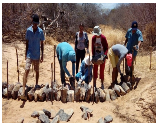
Figura 3 e 4. início da construção da barragem.
