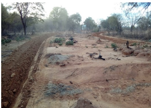
Figura 4: cordões de terra em curva de nível.
