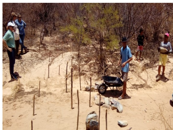
Figura 1 e 2. Marcação da barragem de pedra de base zero.
