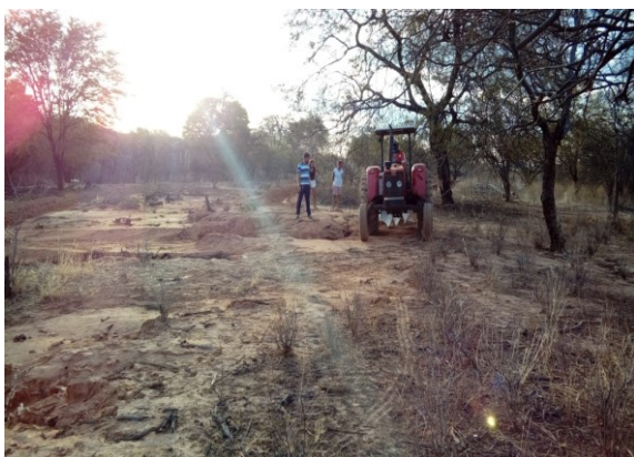
Figura 2: Construção dos cordões de terra em curva de nível.
