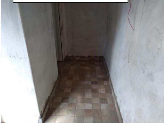
Área de serviço nos Banheiros
