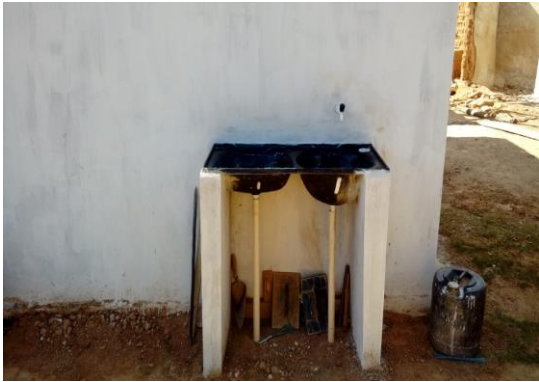
Pia externa ao Banheiro
