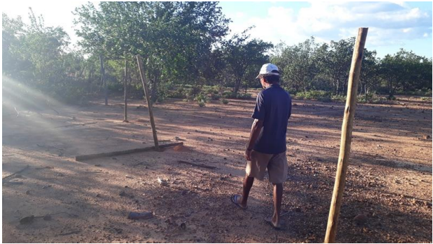
Cerca em construção
