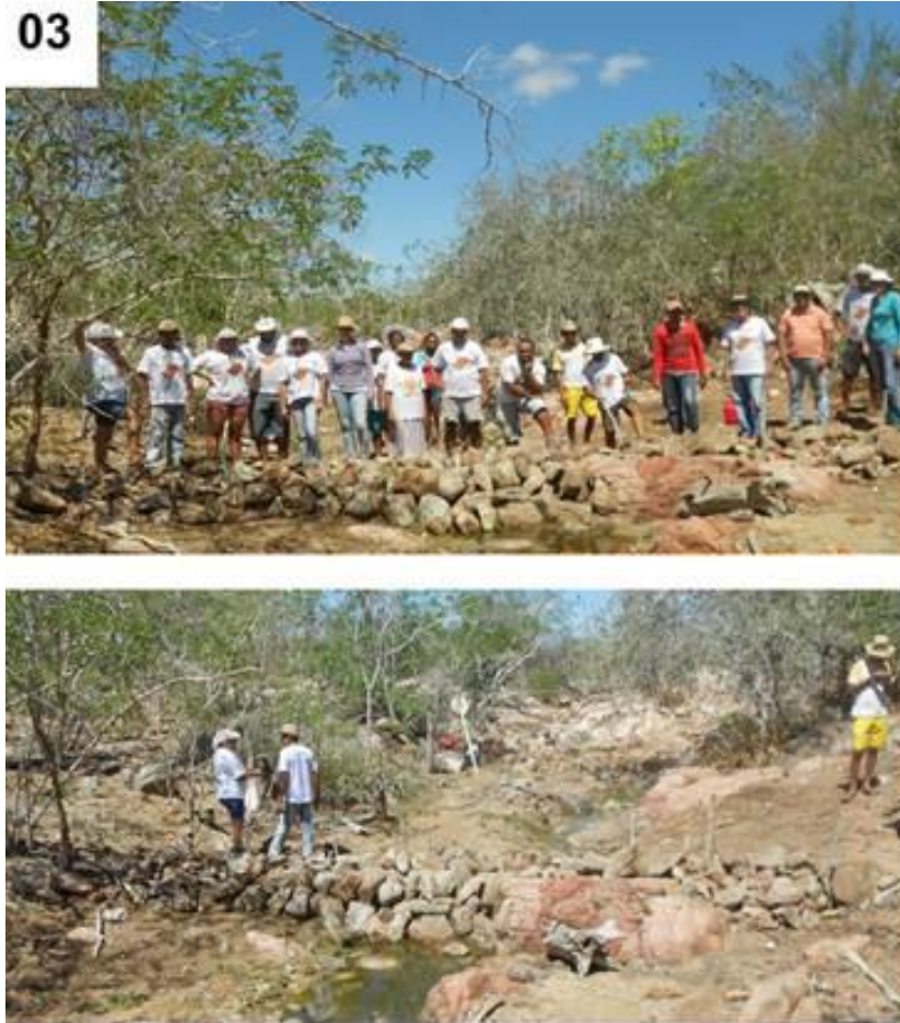
Imagem 10 – 3ª Barragem Sucessiva de pedra riacho Lajedinho no Assentamento Florestan Fernandes.
