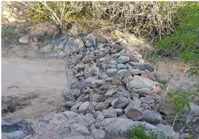
Imagem 09 – 2ª Barragem Sucessiva de pedra riacho Lajedinho no Assentamento Florestan Fernandes.
