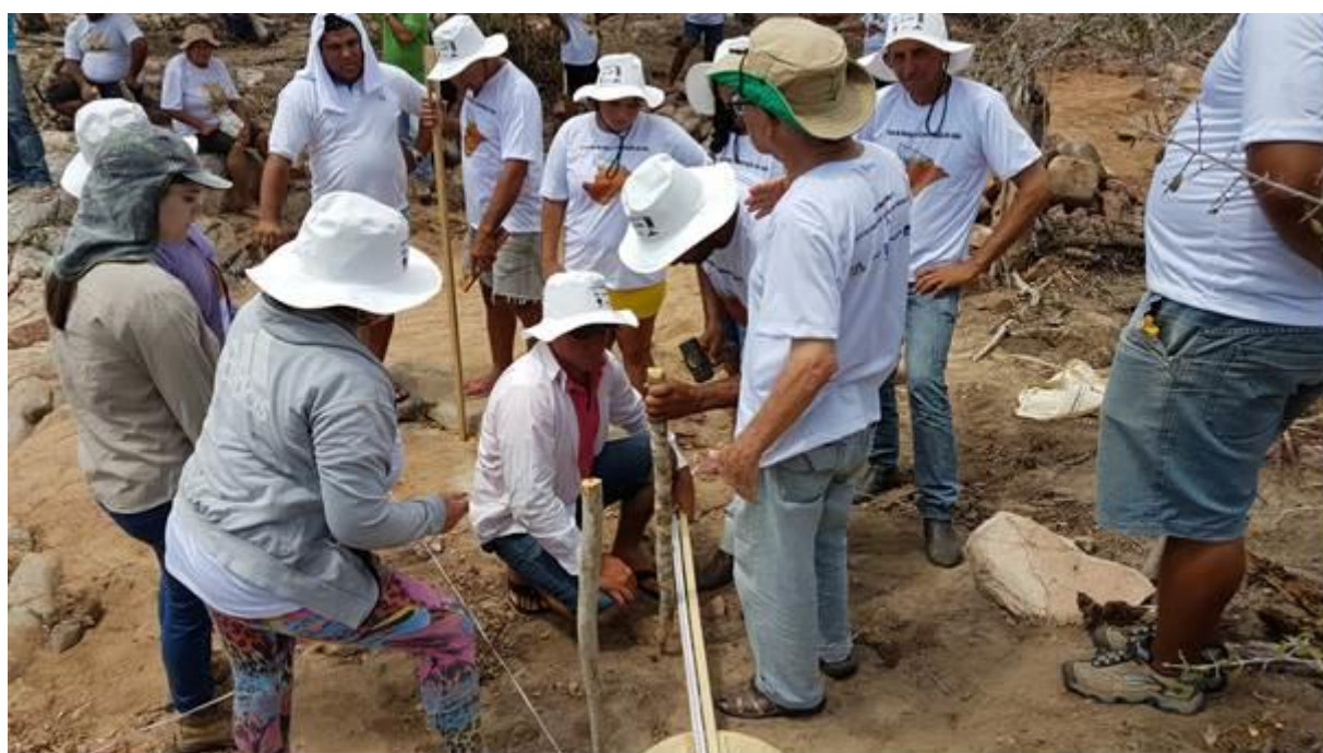
Construção da 1ª Barragem Sucessiva de Pedras.
