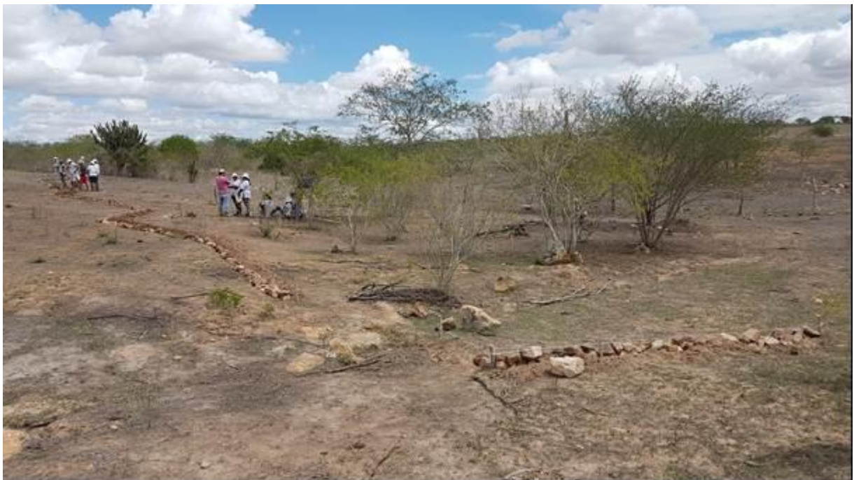
Marcação da curva de nível e construção de mureta de padras.
