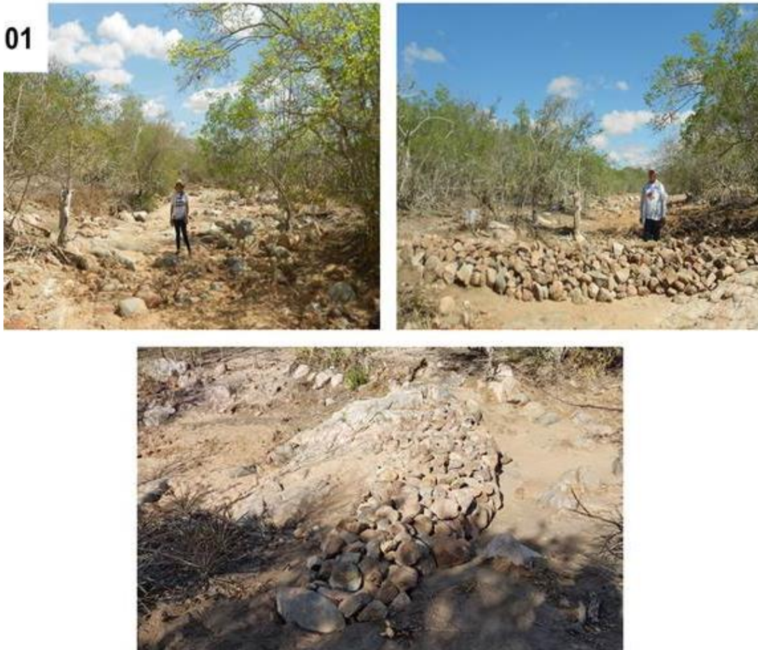
Imagem 08 – 1ª Barragem Sucessiva de pedra no riacho Lajedinho no Assentamento Florestan Fernandes.
