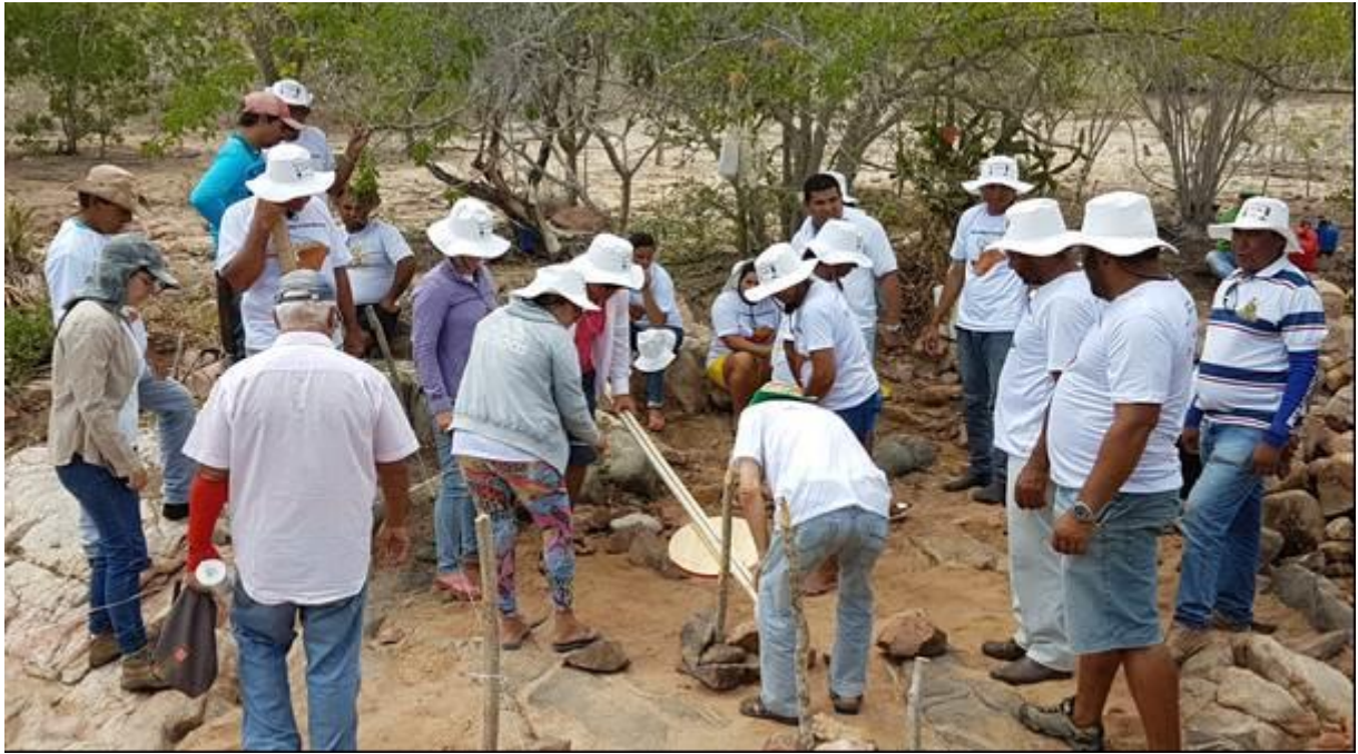
Construção da 1ª Barragem Sucessiva.
