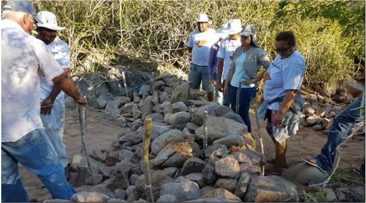
Construção da 2ª Barragem Sucessiva.
