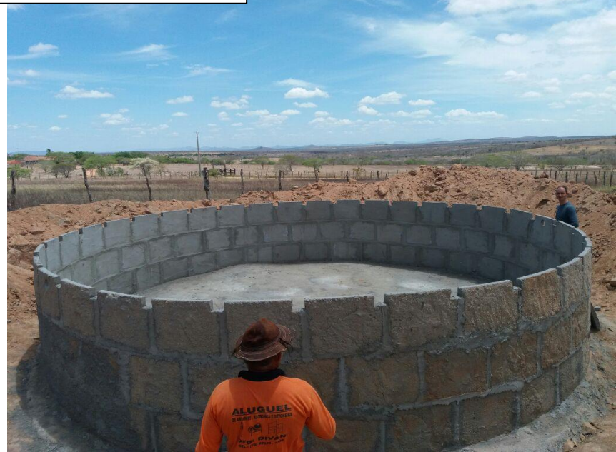
CONSTRUÇÃO DE CISTERNAS
