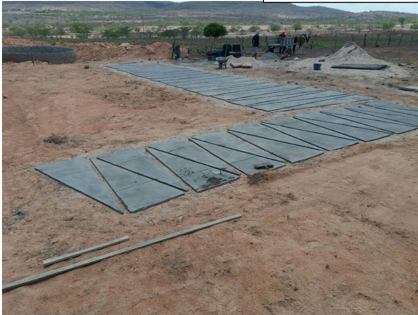
CONSTRUÇÃO DE CISTERNAS
