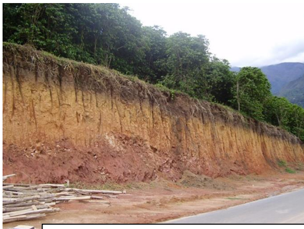
Solo raso e em estágio de compactação.
