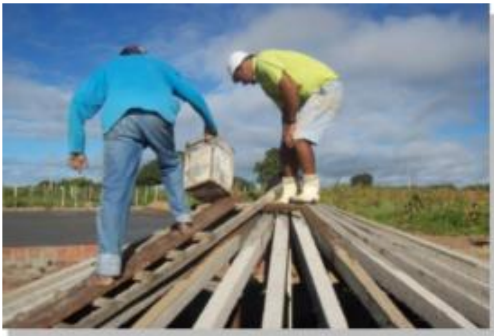
Imagem 8. Concretagem da cúpula da cisterna. Fonte internet.
