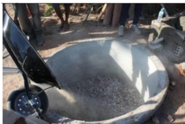
Imagem 18. Colocação dos elementos do filtro. Na imagem colocação da brita. Extraído de ARAÚJO (2017).
