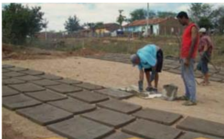
Imagem 2. Processo de confecção das placas. Extraído de ASA (2021).
