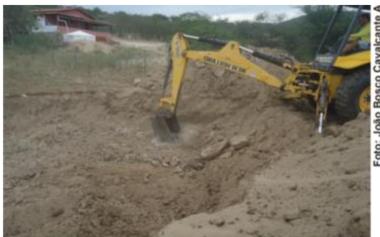
Imagem 1. Escavação mecanizada do terreno para a cisterna. Fonte: ARAÚJO et al (2018).
