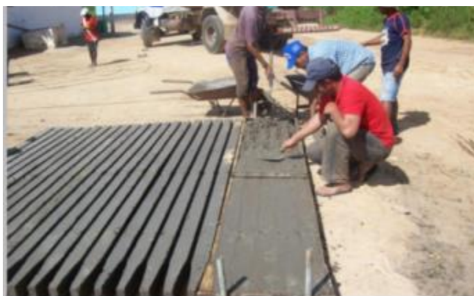
Imagem 3. Processo de enchimento das armaduras e concretagem em fôrma de madeira. Extraído de MATIAS E MELLO (2021).
