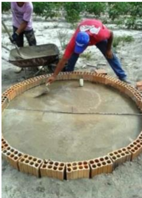
Imagem 12. Confeção da tampa em concreto armado dos filtros. Extraído de GOUVEIA (2017)
