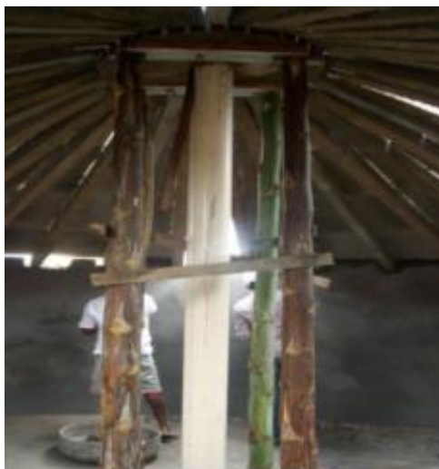
Imagem 6. Vista interna da colocação da roda de madeira. Na imagem vê-se escorada por 4 estacas. Extraído de MATIAS & MELLO (2021)
