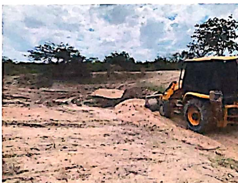
LOCALIZAÇÃO SERVIÇO POV. SÃO JOSÉ, POÇO REDONDO/SE MOVIMENTAÇÃO DO SOLO
