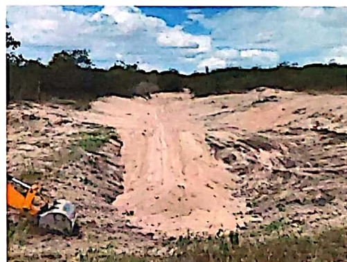
LOCALIZAÇÃO SERVIÇO POV. SÃO JOSÉ, POÇO REDONDO/SE MOVIMENTAÇÃO DO SOLO
