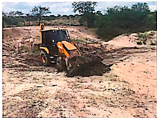
LOCALIZAÇÃO SERVIÇO POV. SÃO JOSÉ, POÇO REDONDO/SE REMOÇÃO DE SOLO (LAMA PODRE)
