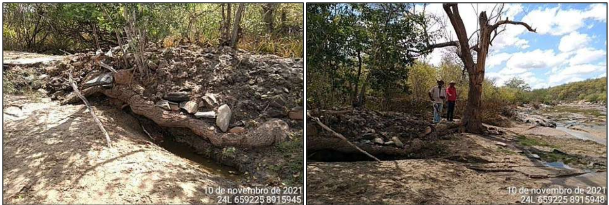
Figura 2. Aspectos da área 1 a ser restaurada no P.A. Che Guevara.
