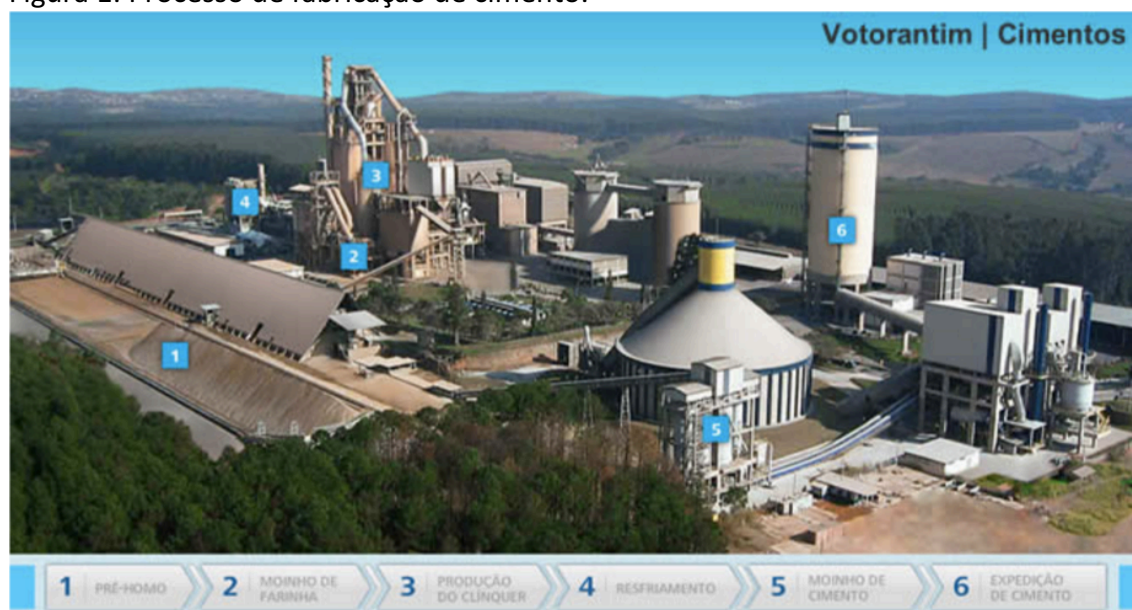
Figura 1: Processo de fabricação de cimento.
