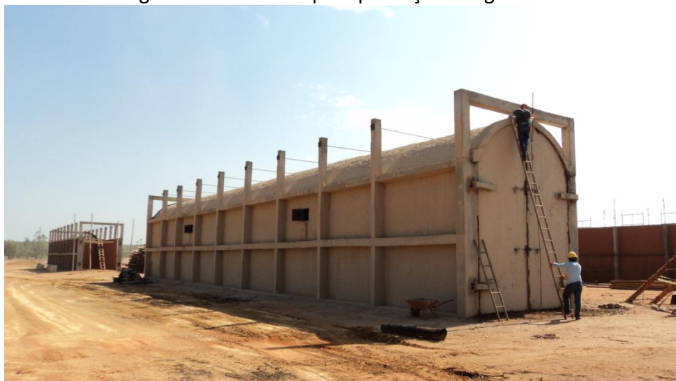
Figura 4: Forno retangular em alvenaria para produção em grande escala.
