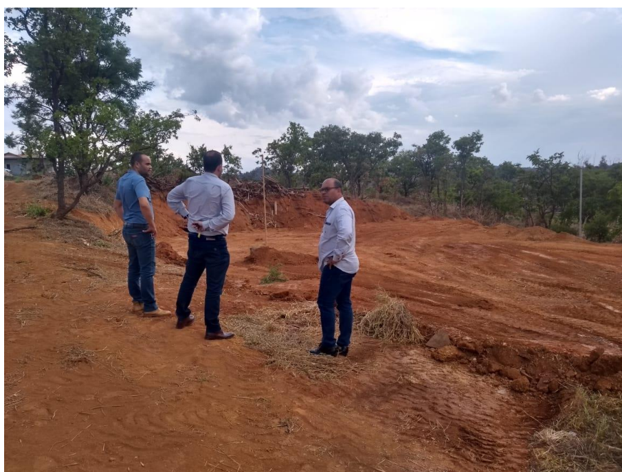
Figura 7. Visita da representante do INAES e parceiros da EMATER e SENAR na área onde será construída a Unidade Demonstrativa de Produção de Carvão Sustentável, em 29/11/2019.
