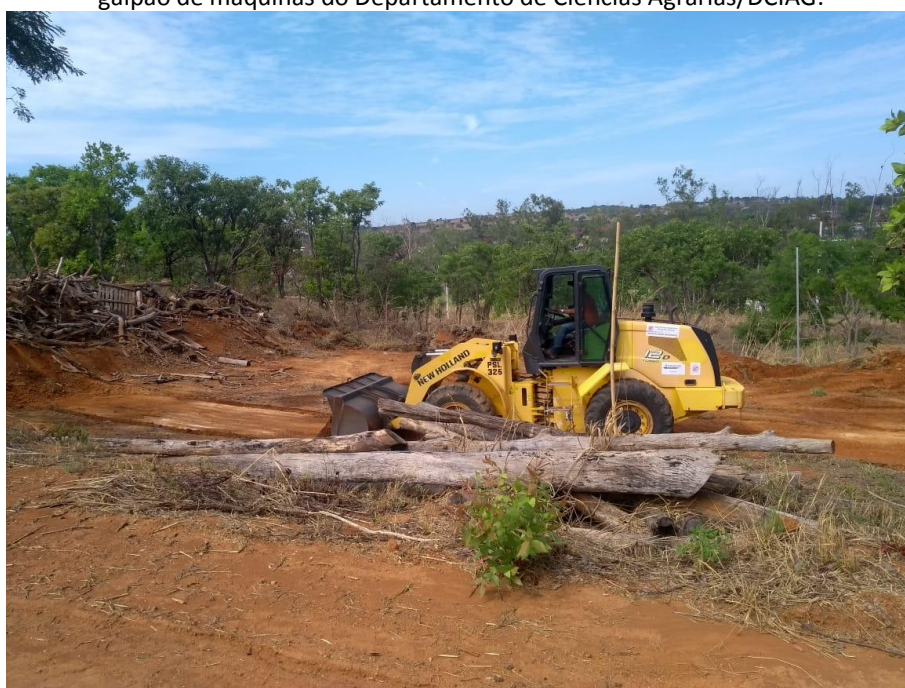
Figura 3. Local para instalação da Unidade Demonstrativa de produção de Carvão Vegetal e Galpão de apoio, em processo de nivelamento do terreno.
