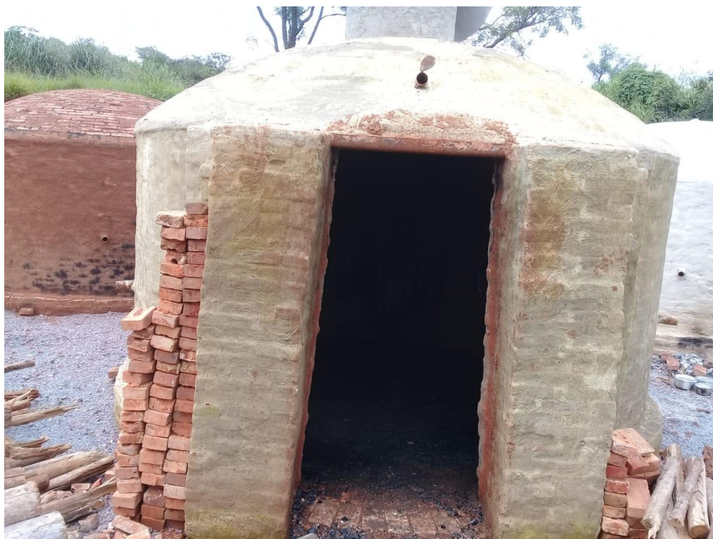
Figura 30. Estrutura do forno após o processo de carbonização.
