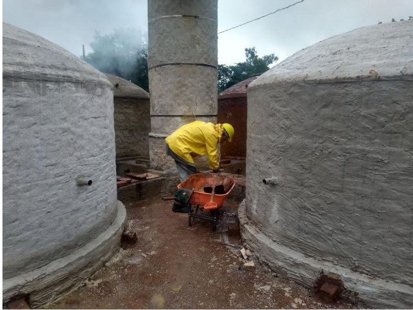
Figura 20. Verificação dos dutos, fornalha e fornos durante o processo de carbonização.
