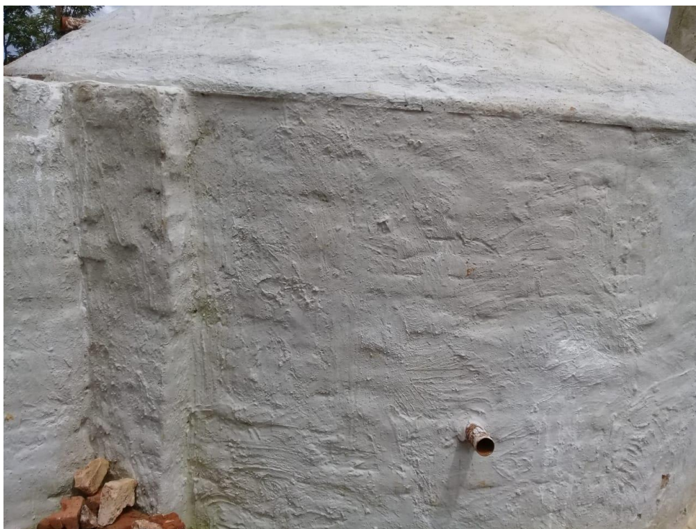
Figura 27. Estrutura do forno após o processo de carbonização.
