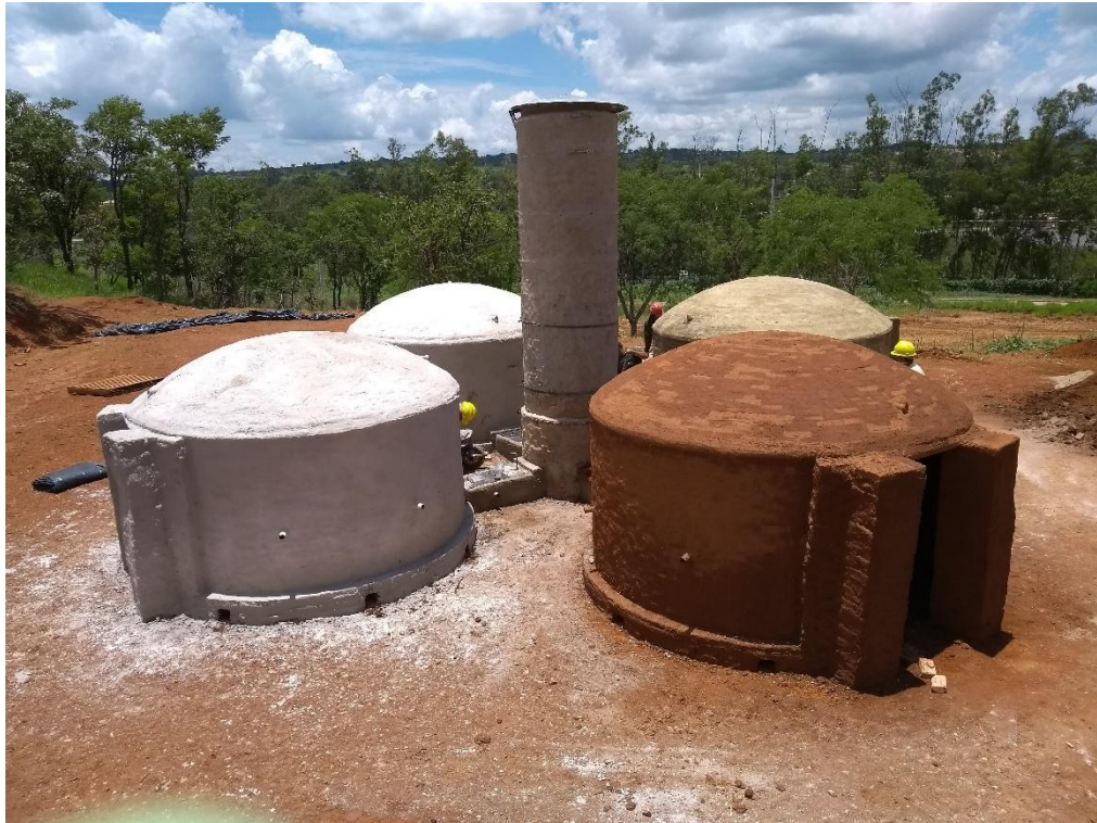
Figura 1. Processo de cura dos fornos de carbonização.
