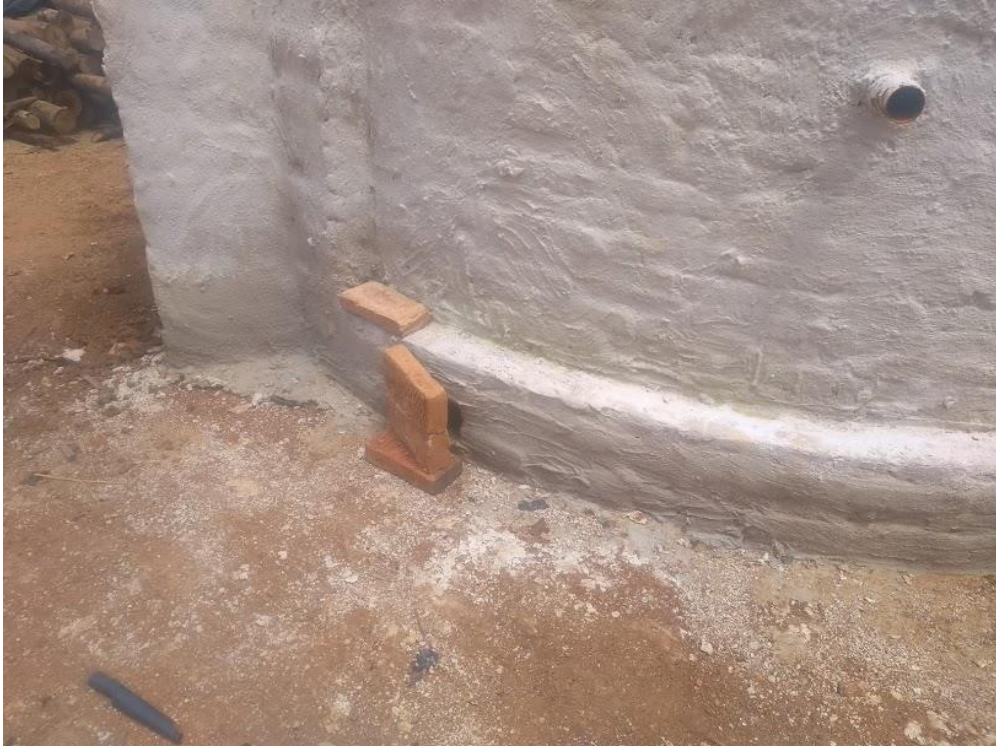
Figura 22. Redução da entrada de ar no tatu.
