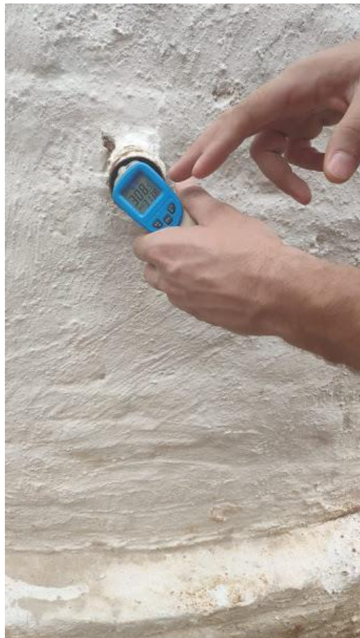
Figura 21. Observação da temperatura durante o processo de carbonização.
