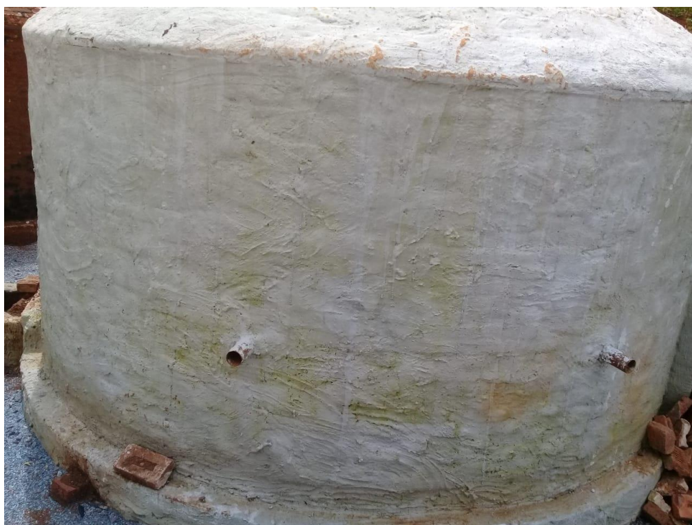
Figura 29. Estrutura do forno após o processo de carbonização.
