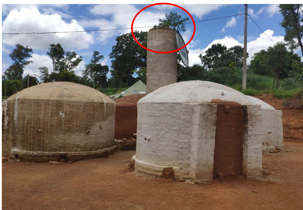
Figura 3. Sistema fornos-fornalha operando sem a emissão de poluentes.
