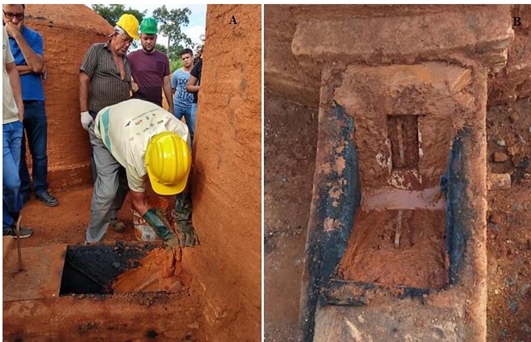
Figura 10. Vedação minuciosa para evitar a saída dos gases após finalização da carbonização da madeira e início da fase de resfriamento (A), duto que liga forno-fornalha completamente vedado (B).
