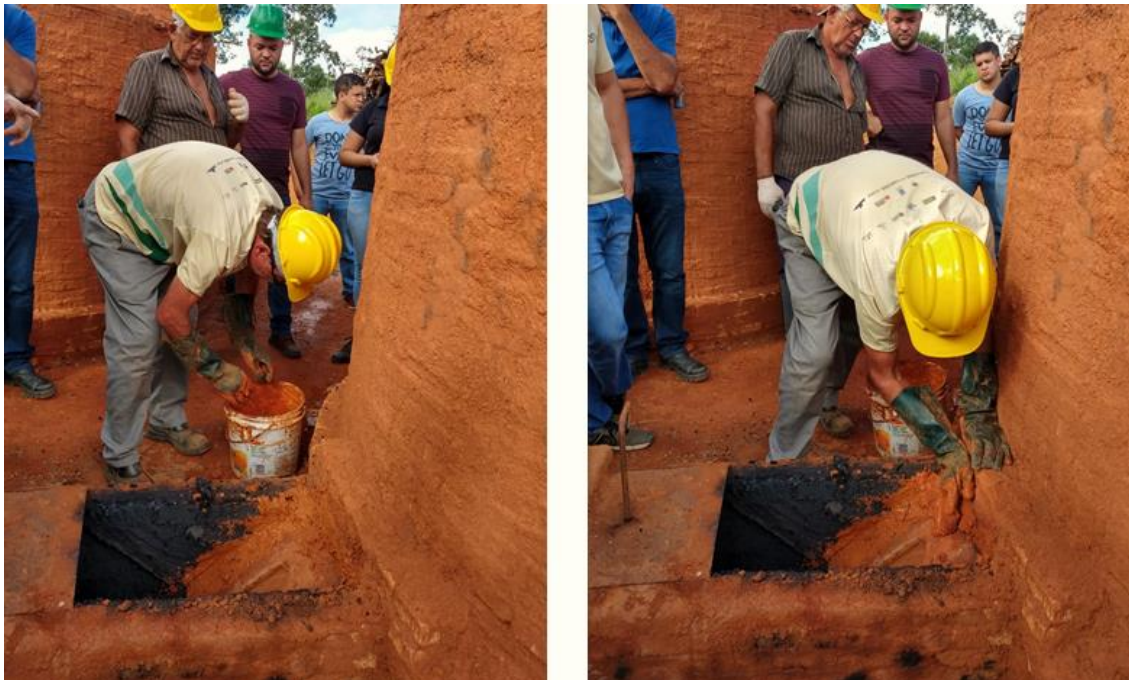
Figura 9. Fechamento e vedação das bordas da chapa metálica da fornalha.
