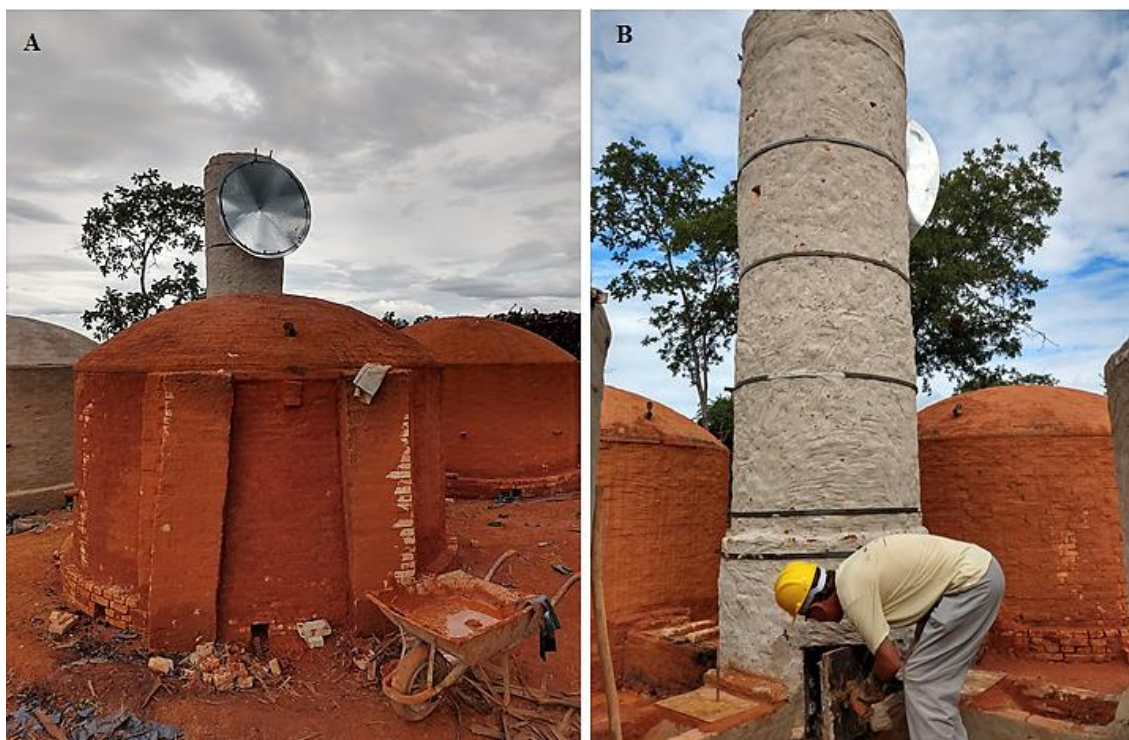
Figura 1: Ativação da fornalha após fechamento do forno para carbonização (A), monitoramento da câmara de combustão da fornalha (B).
