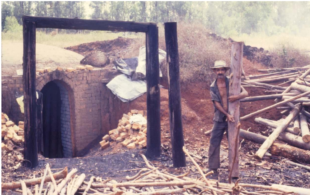
FIGURA40: FORNO DE ENCOSTA OU BARRANCO, EM MINAS GERAIS.
