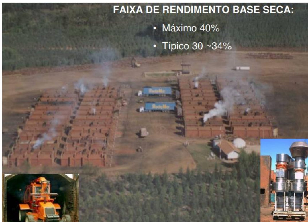
FIGURA45: FORNOS RETANGULARES EMPREGADOS PELOS GRANDES PRODUTORES INTEGRADOS
