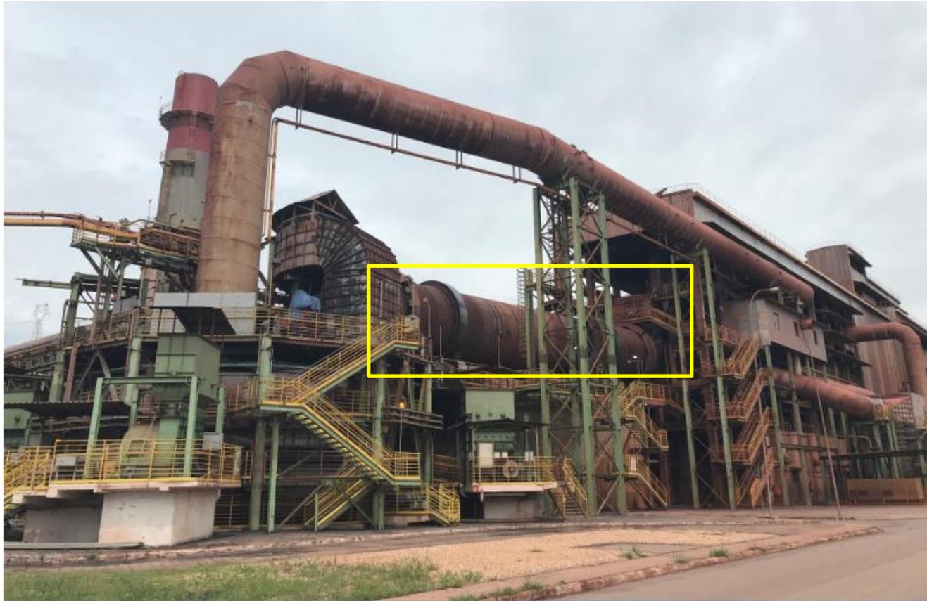
Foto 5: Vista parcial da planta de pelotização, com destaque para o forno rotativo que recebe o pó de injeção e gás natural.
