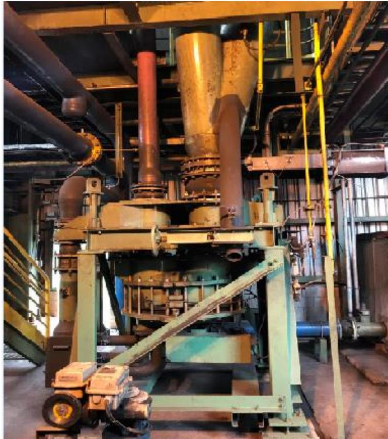
Foto 4: Sistema de dosagem e transferência do pó de injeção.
