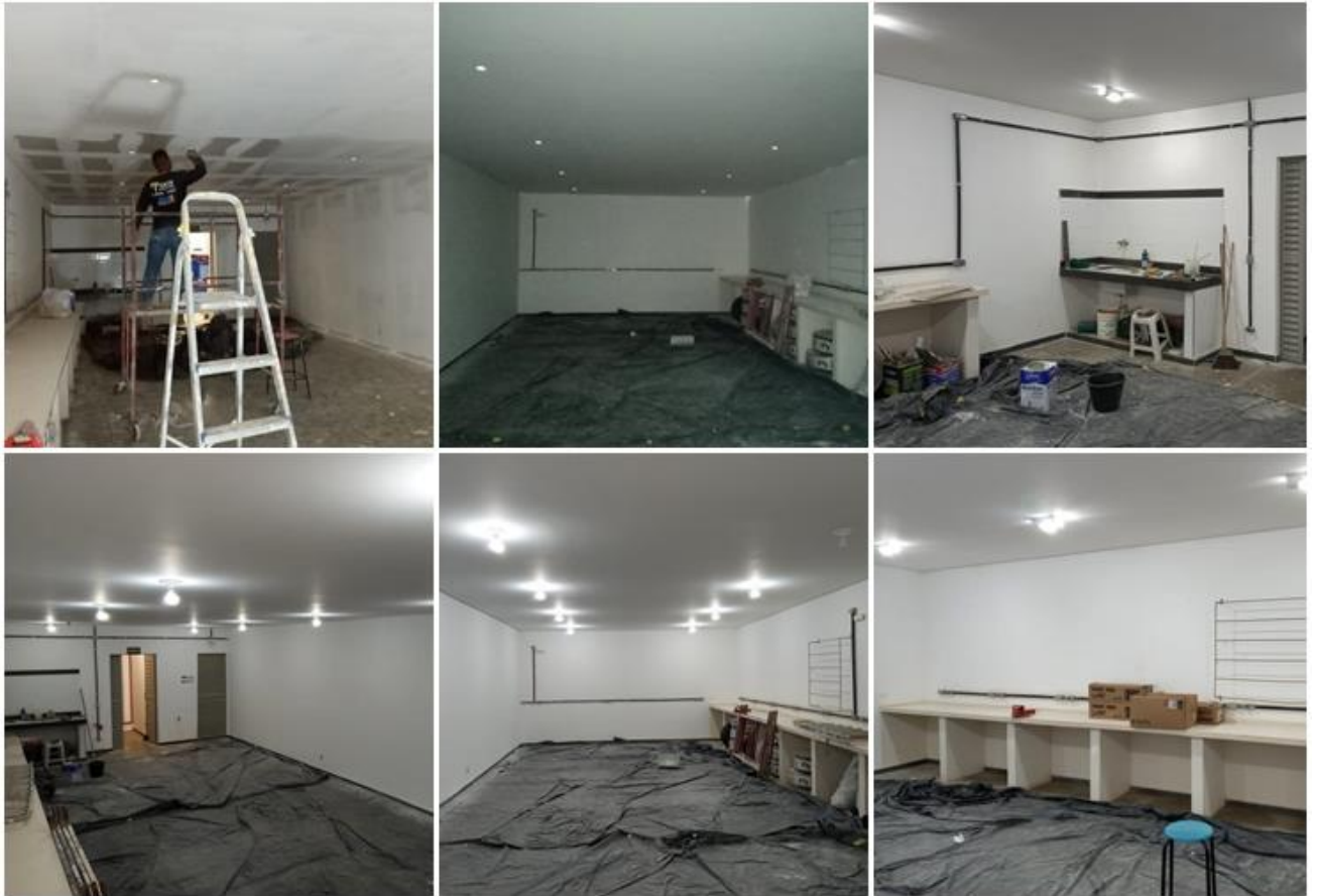
Figura 3. Reformas e adequações no galpão 1 próximo a unidade demonstrativa.
