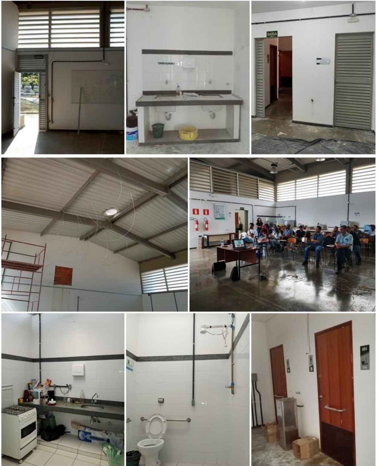
Figura 1. Estruturas já existentes próximas à unidade demonstrativa do sistema fornos-fornalha.
