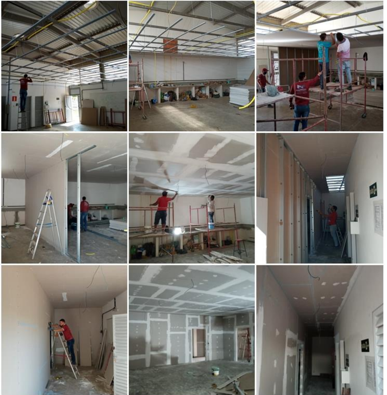
Figura 4. Início das reformas no galpão 2 próximo a unidade demonstrativa.
