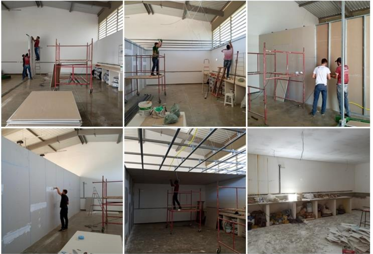
Figura 2. Início das reformas no galpão 1 próximo a unidade demonstrativa.
