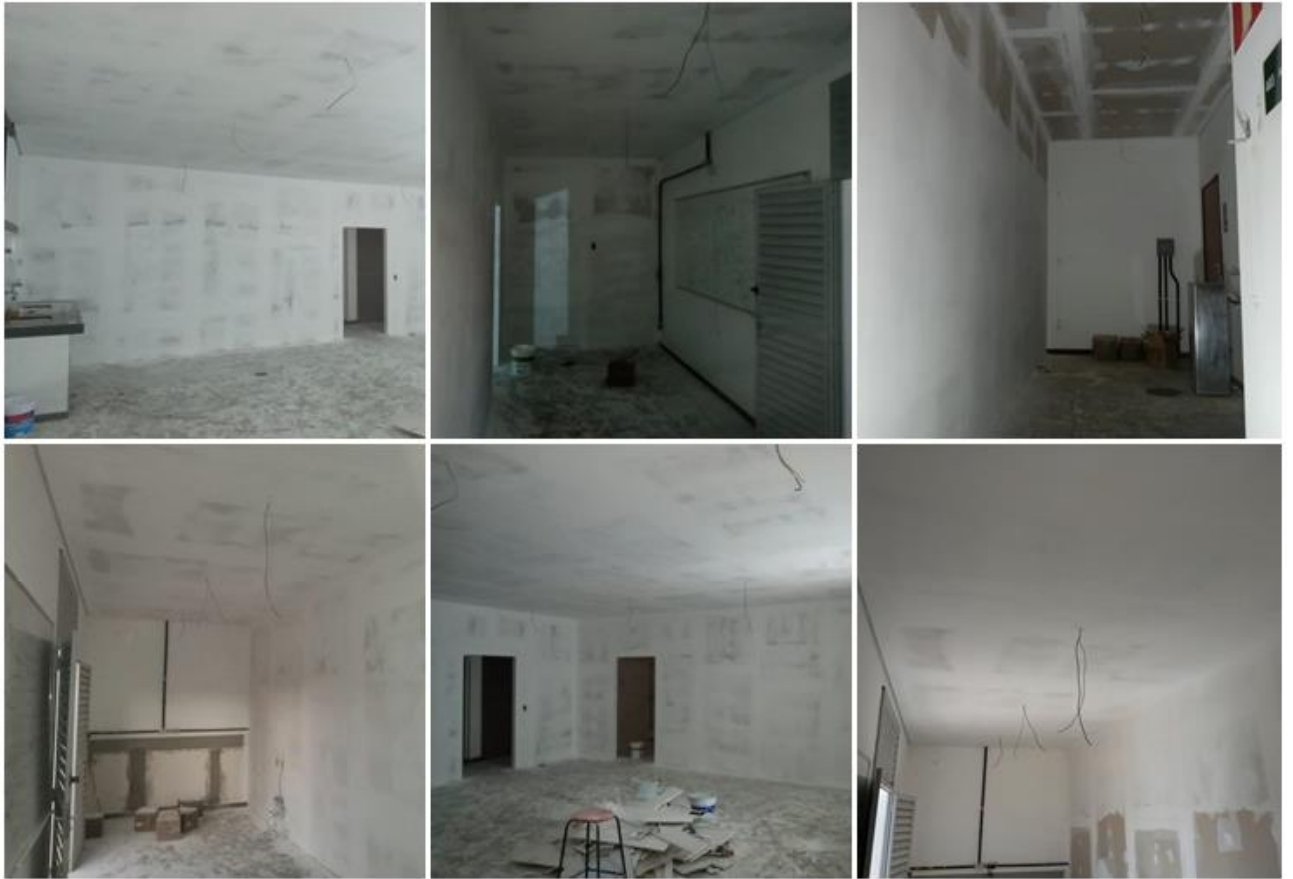
Figura 5. Reformas e adequações no galpão 2 próximo a unidade demonstrativa.
