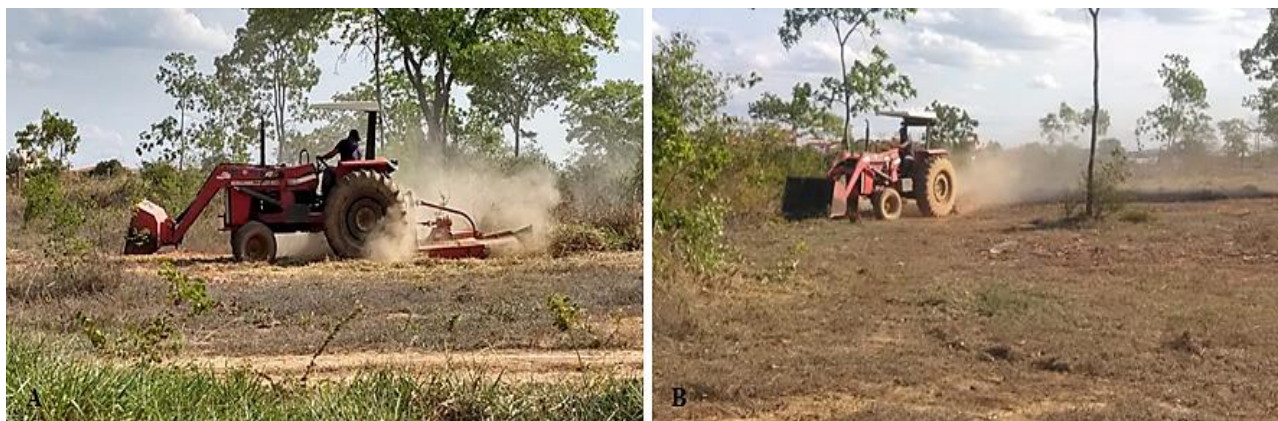
Figura 3: Atividade de roçada com uso do trator e roçadeira para a limpeza do local de construção dos fornos (A). Área com limpeza e com a preservação de árvores locais (B).
