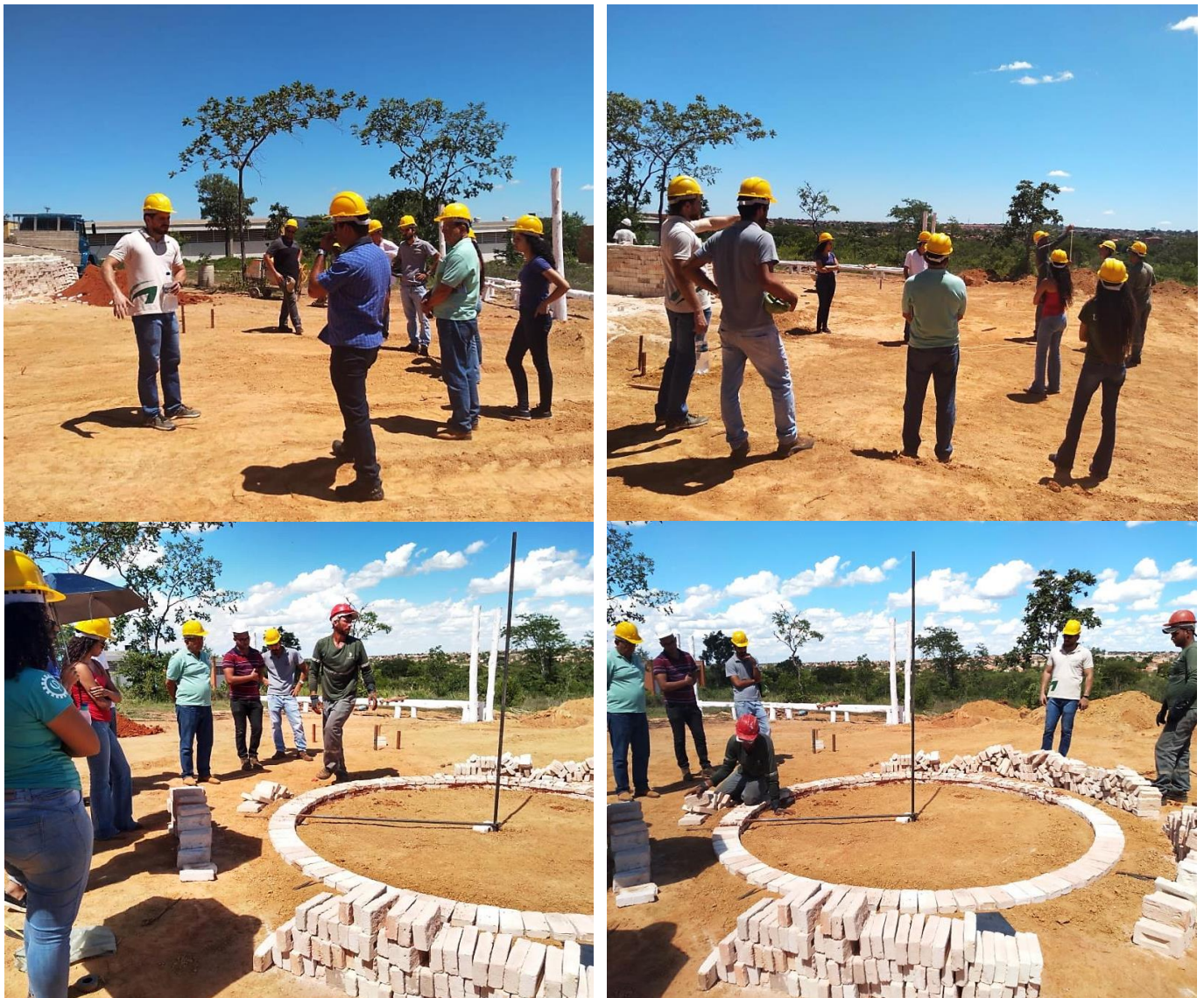
Figura 9. Acompanhamento da construção do sistema fornos-fornalha no ICA/UFMG.
