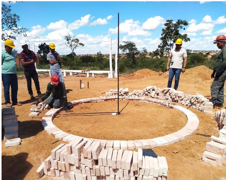
Figura 4. Curso Prático de Construção do Sistema Fornos-fornalha no campus de Montes Claros da UFMG.
