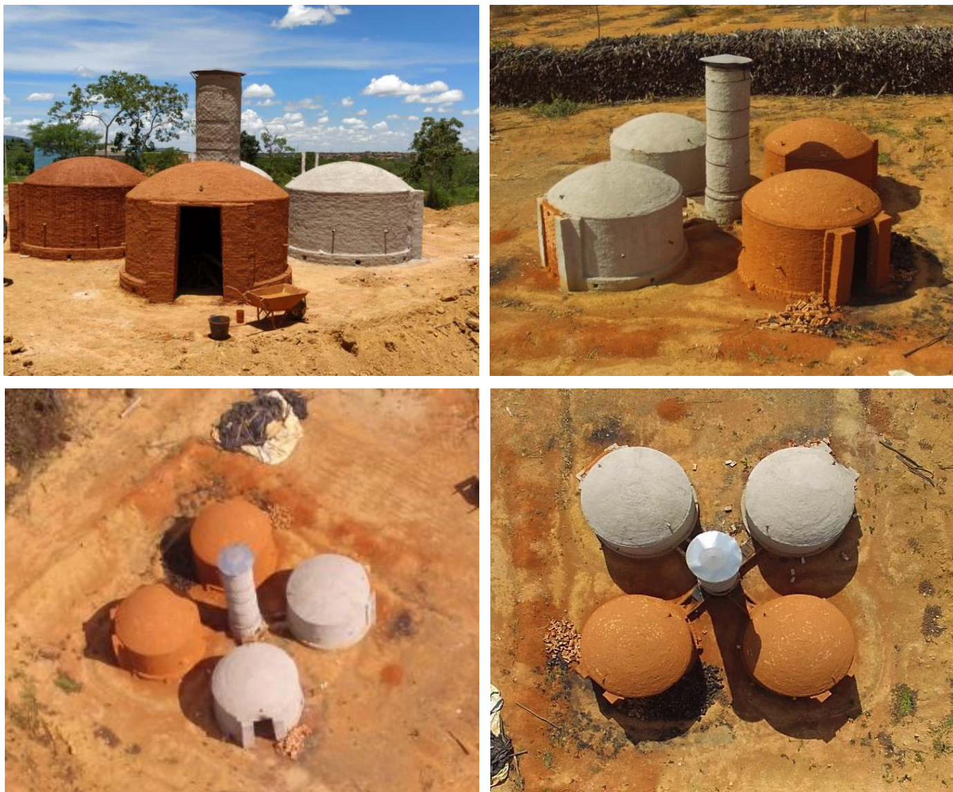
Figura 1. Instalação da unidade demonstrativa no campus de Montes Claros da UFMG.
