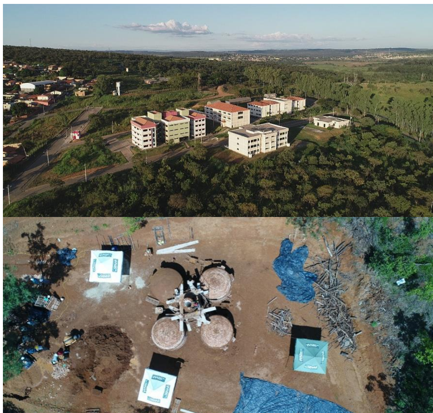
Figura 3: Vista aérea dos pavilhões de aula e laboratório bem como do início da conexão com a área do fragmento florestal do Cerrado, e da unidade demonstrativa de produção sustentável de carvão vegetal em construção, respectivamente nas imagens abaixo, localizada no campus da UFSJ/CSL.
