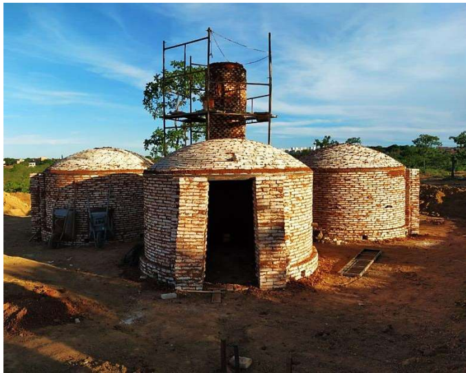
Figura 13. Terceiro dia da construção do sistema fornos-fornalha do projeto BRA/14/G31 – Siderurgia Sustentável.
