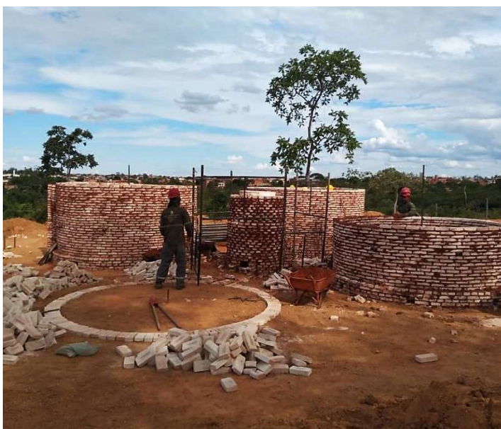
Figura 12. Segundo dia da construção do sistema fornos-fornalha do projeto BRA/14/G31 – Siderurgia Sustentável.
