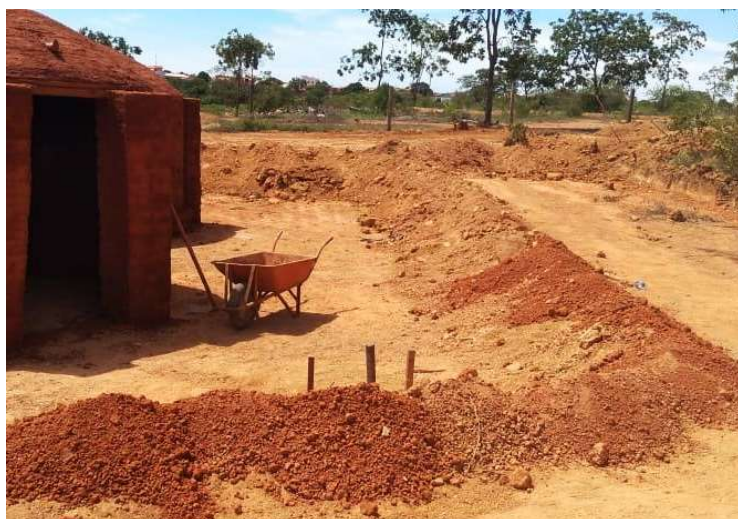
Figura 5 – Canaletas construídas ao redor da unidade do projeto BRA/14/G31 – Siderurgia Sustentável.
