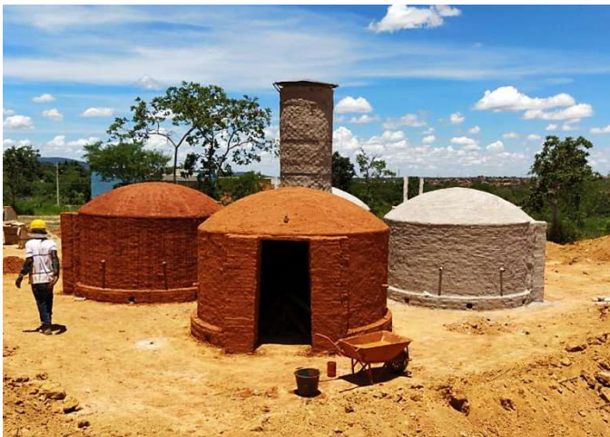
Figura 13. Terceiro dia da construção do sistema fornos-fornalha do projeto BRA/14/G31 – Siderurgia Sustentável.
