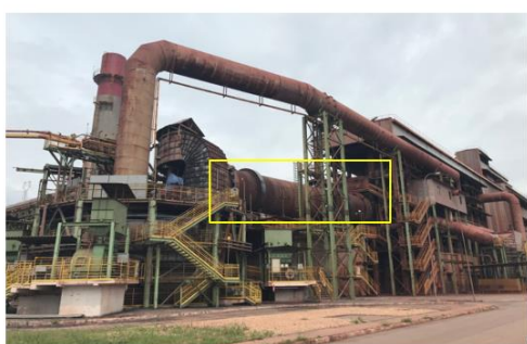
Foto 5: Vista parcial da planta de pelletização, com destaque para o forno rotativo que recebe o pó de injeção e gás natural. Fonte: VSB
