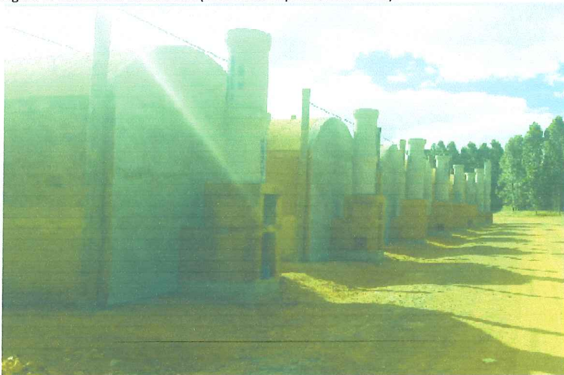
Figura 2: Detalhe do fundo dos 8 (oito) fornos – região das chaminés.
