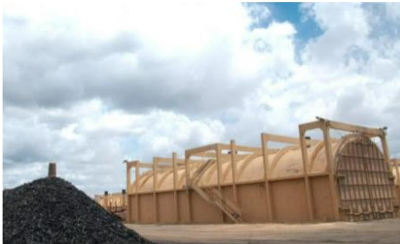
**Figura 4:** Forno retangular de alvenaria modelo RAC700.
