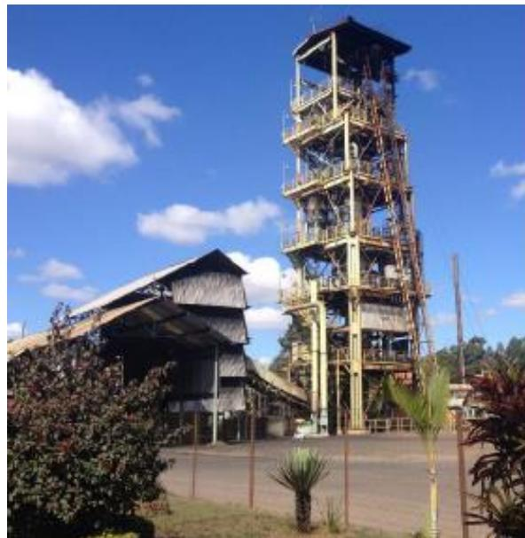
**Figura 10:** Reator de carbonização contínua Carboval.
