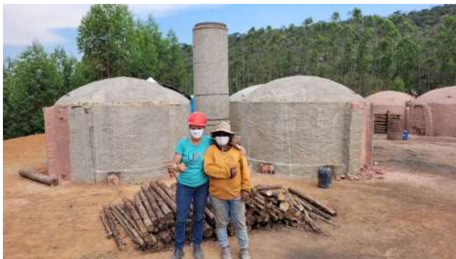
Figura 3 - Treinamento de operação do sistema forno-fornalha realizado na propriedade em Dores do Turvo - Produtor João Ângelo.
