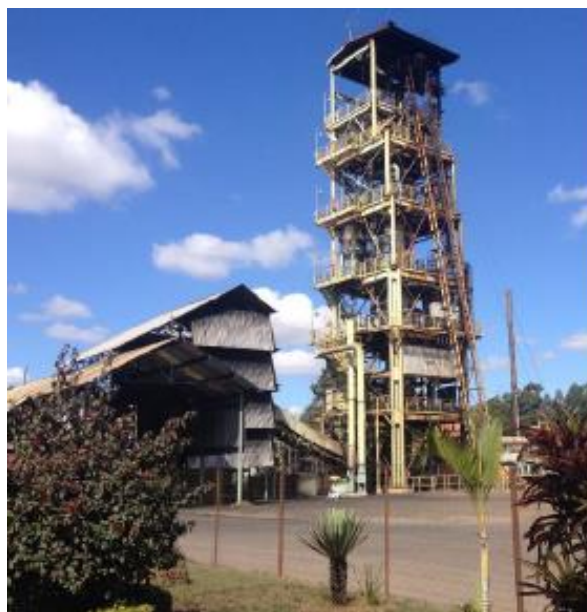
Figura 10: Reator de carbonização contínua Carboval.
