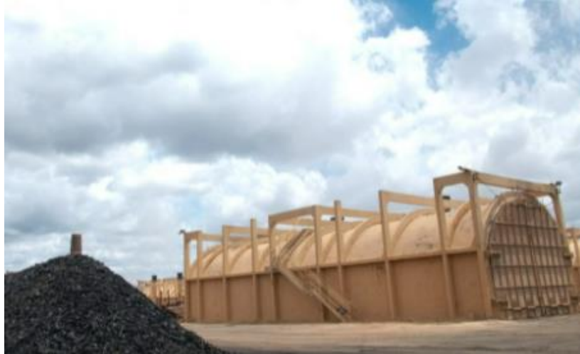
Figura 4: Forno retangular de alvenaria modelo RAC700.
