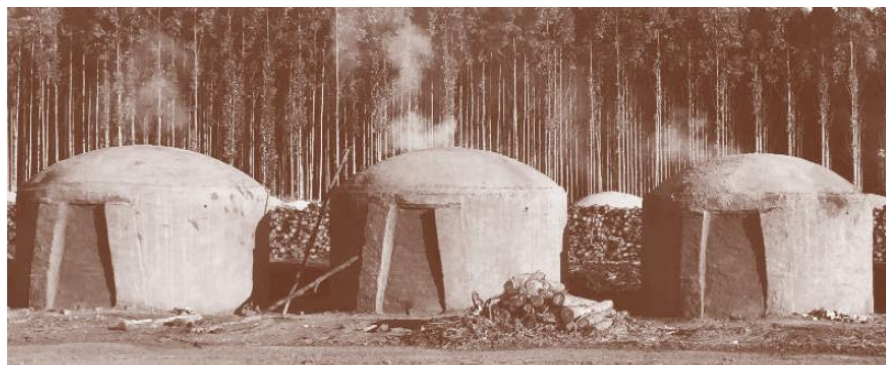
Figura 1: Fornos cilíndricos de alvenaria do tipo “rabo quente”.
