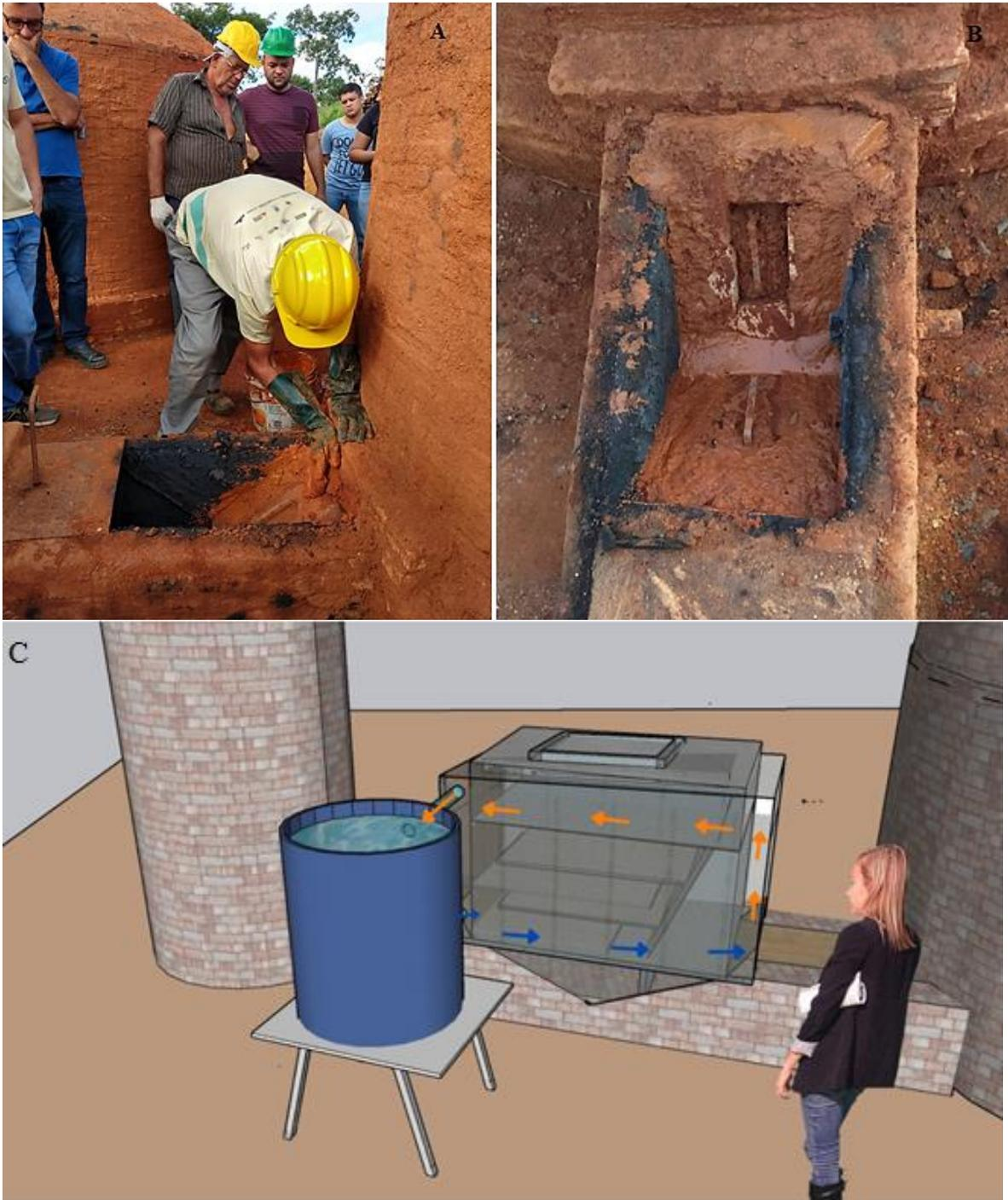
Figura 10. A) Vedação minuciosa dos dutos para evitar a saída dos gases; B) Arranjo atual dos dutos que ligam o forno à fornalha; C) Novo arranjo após intervenção dos dutos com o condensador de gases
