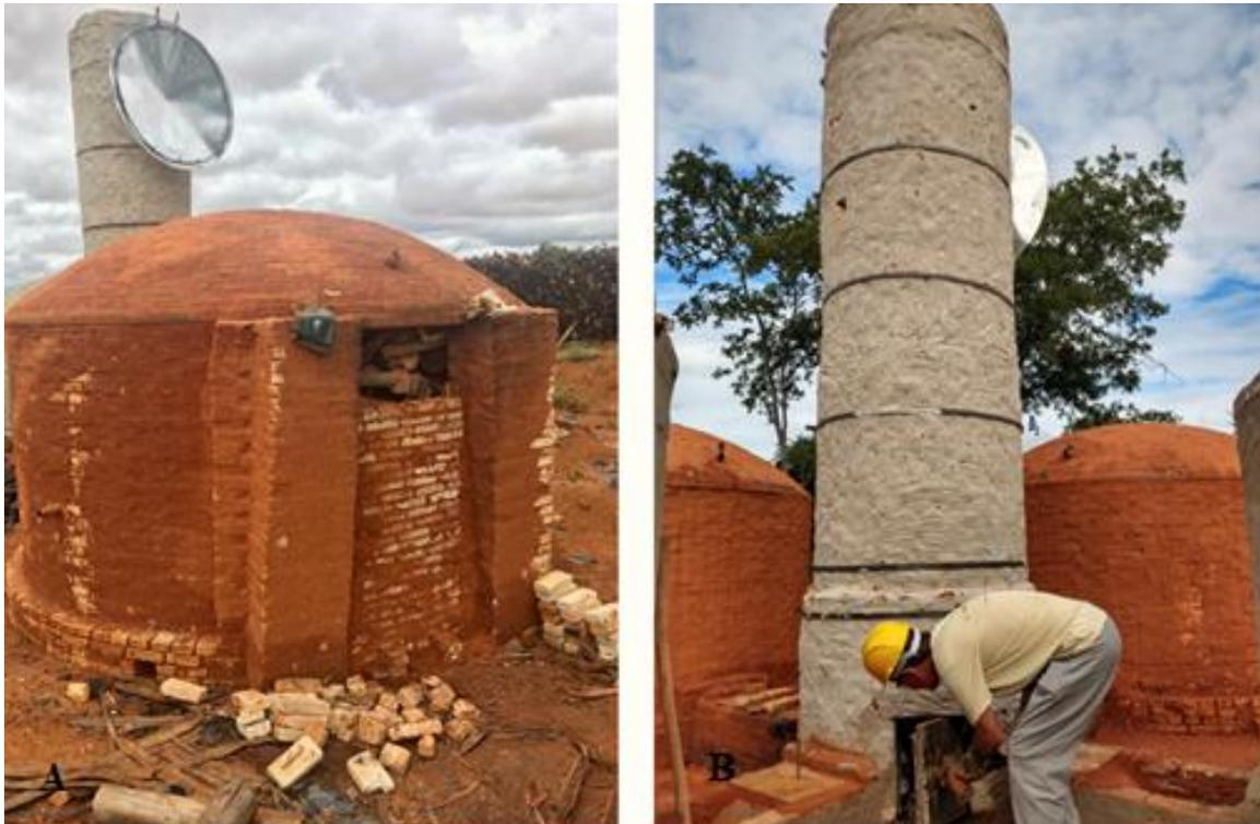
Figura 4. A) Fechamento dos fornos; B) Abastecimento da fornalha para ignição.
