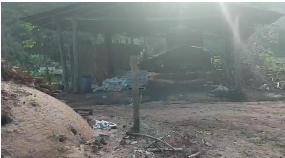
Fig.11 – Fotografia do galpão atual que será reformado
