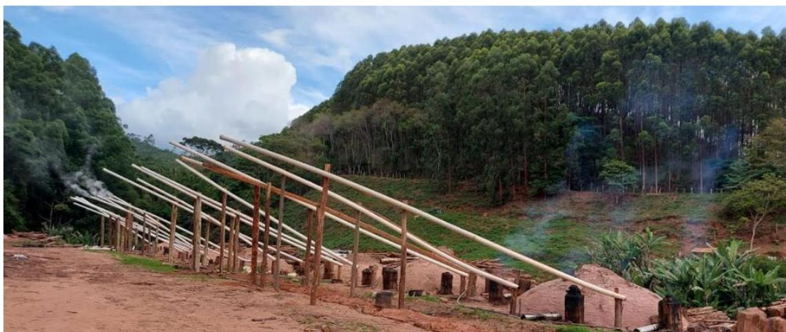
**Fig. 07** – Imagem da UPC Vale das Benções com sistema inovador de condensação da fumaça em todos os fornos
