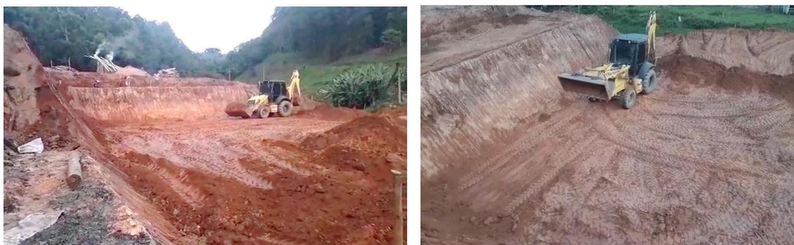
**Fig. 09** – Imagens da terraplanagem para montagem do galpão da Planta de Beneficiamento
