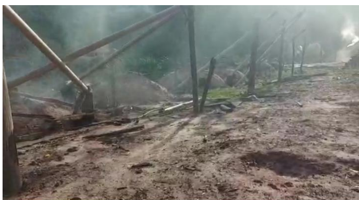
Fig. 03 – Linha de fornos de encosta com sistema rudimentar de coleta do extrato (fumaça líquida)
