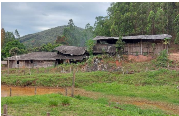
Fig. 28 – Imagem do galpão antigo, antes do projeto PNUD
