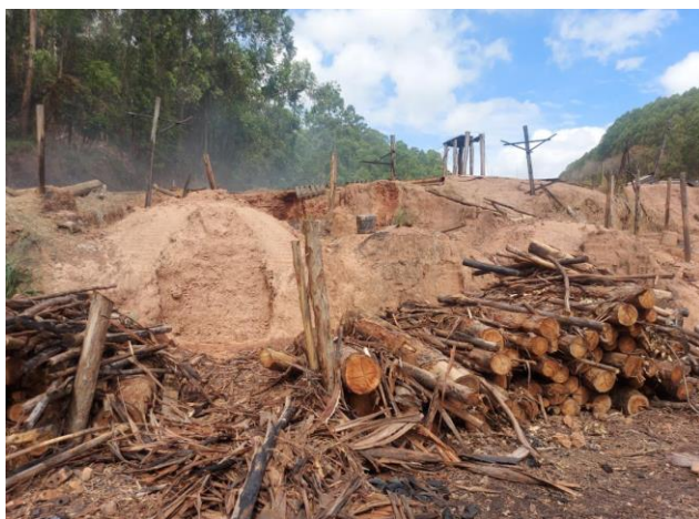
Fig.16 – Imagem dos fornos de encosta sem sistema de coleta dos gases condensáveis
