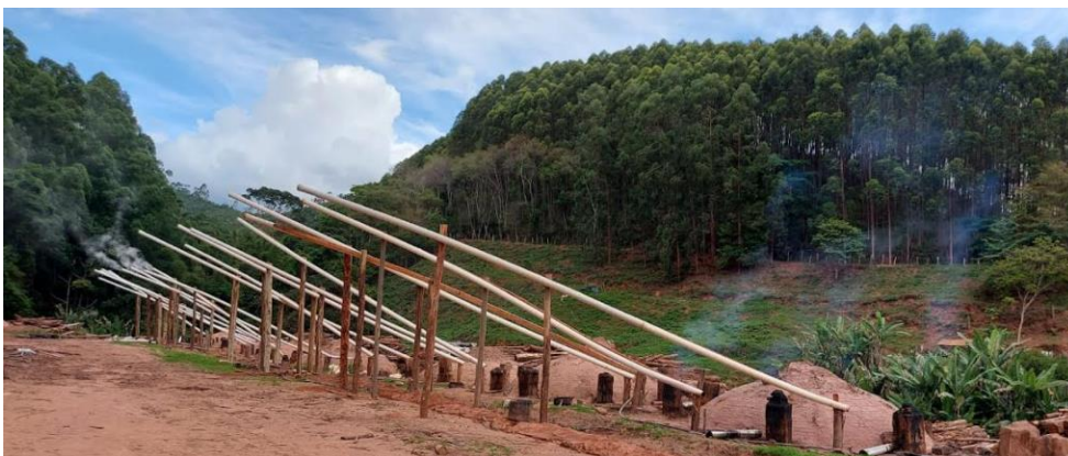
Fig. 27 – Nova UPC com instalação do novo sistema de coleta em todos os fornos
