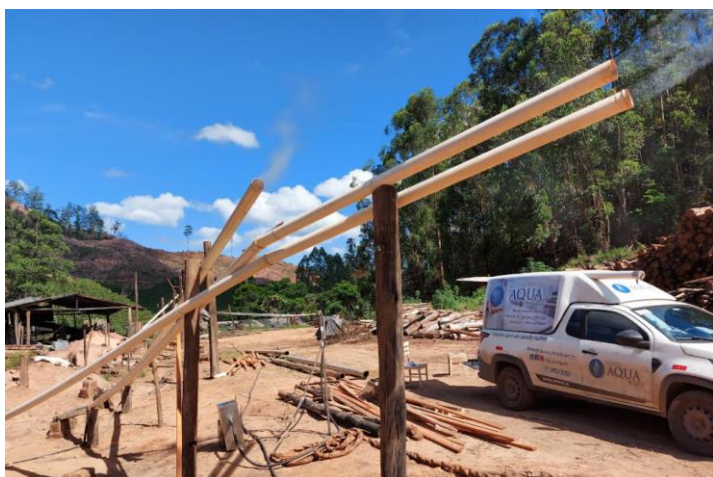
Fig. 22 – Emissão dos gases no Forno 19, com novo sistema de condensação
