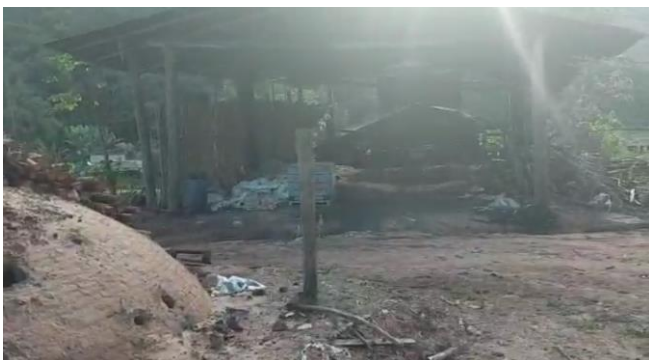
Fig. 11 – Fotografia do galpão atual que será reformado
