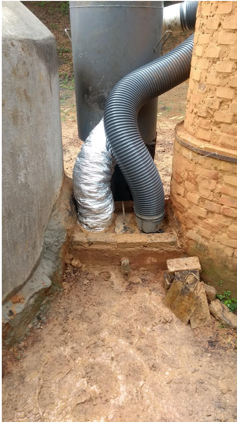
Figura 22 - Acoplagem do recuperador ao forno e à fornalha
