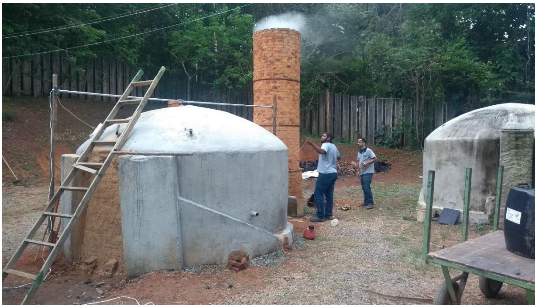
Figura 4 - Montagem da infraestrutura para o sistema supervisório
