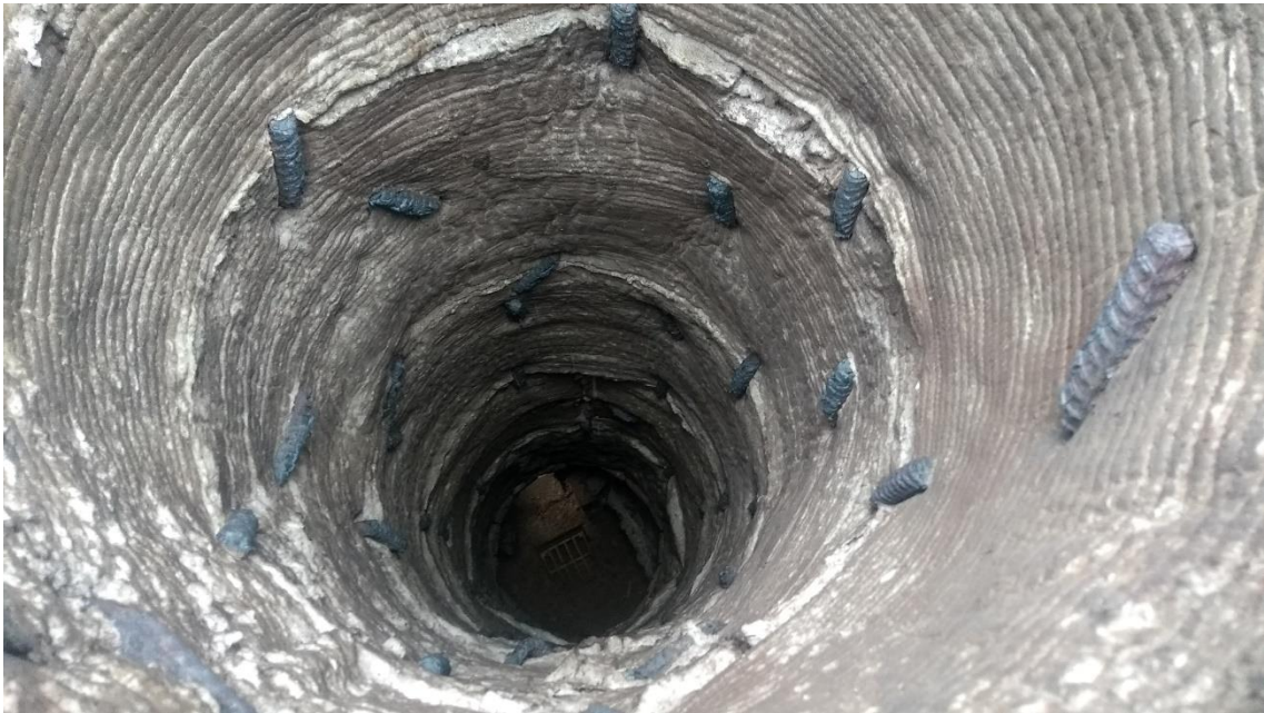
Figura 24 - Vista interna da chaminé
