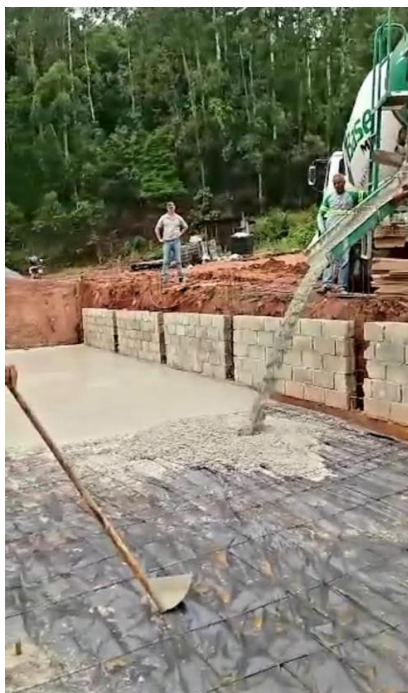
Fig. 31 – Imagem do pátio de estoque dos tanques de coleta da Planta de Beneficiamento
