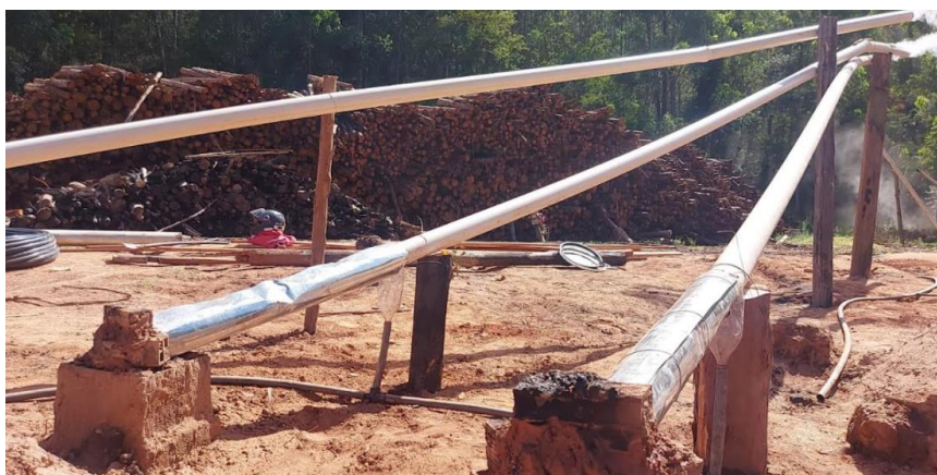
Fig. 23 – Detalhe da junção entre a chaminé e os tubos de PVC
