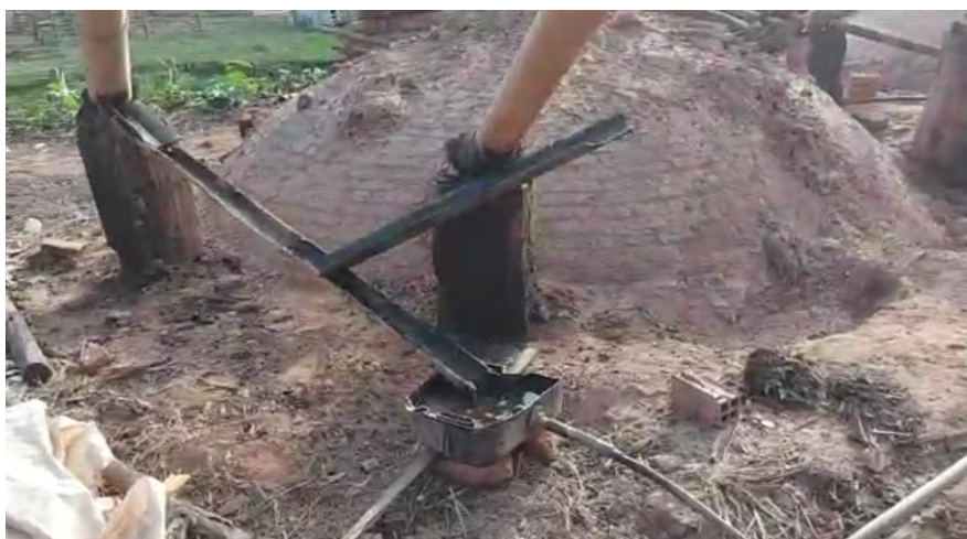
Fig. 09 – Detalhe do sistema de escoamento do extrato (fumaça líquida) com canalização aberta do produto para os tanques de coleta
