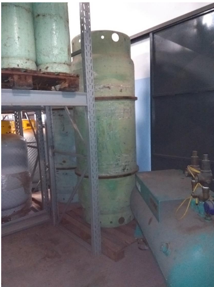
5.3 Armazenamento em tanques de 1000 Kg
