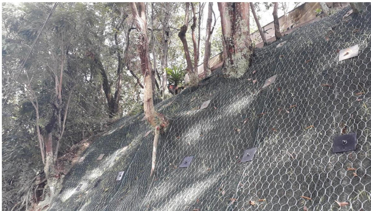
Foto 5: Obra de contenção com grampos, MacMat e árvores. (Fonte: Maccaferri)
