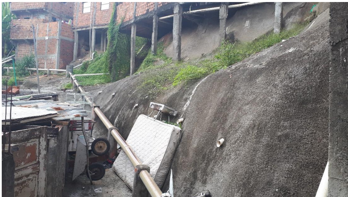
Foto 2: Solo grampeado com acabamento de argamassa e drenagem. (Fonte: W. Lange)
