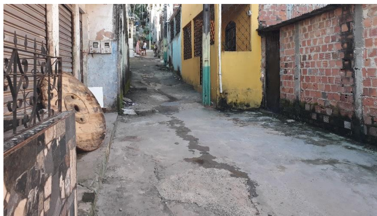
Foto 11: Pequena área potencial para a construção de um canteiro de chuva na comunidade de Beira Dique (Fonte: W. Lange)
