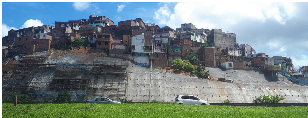
Foto 2: Contenção de encosta com uma construção com tirantes e cortina atirantada. (Fonte: W. Lange)
