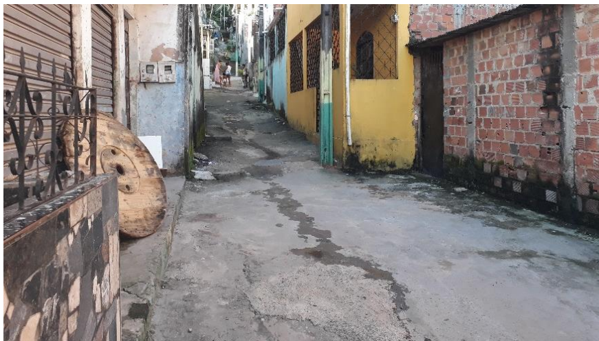
Foto 12: Pequena área potencial para a construção de um canteiro de chuva na comunidade de Beira Dique
