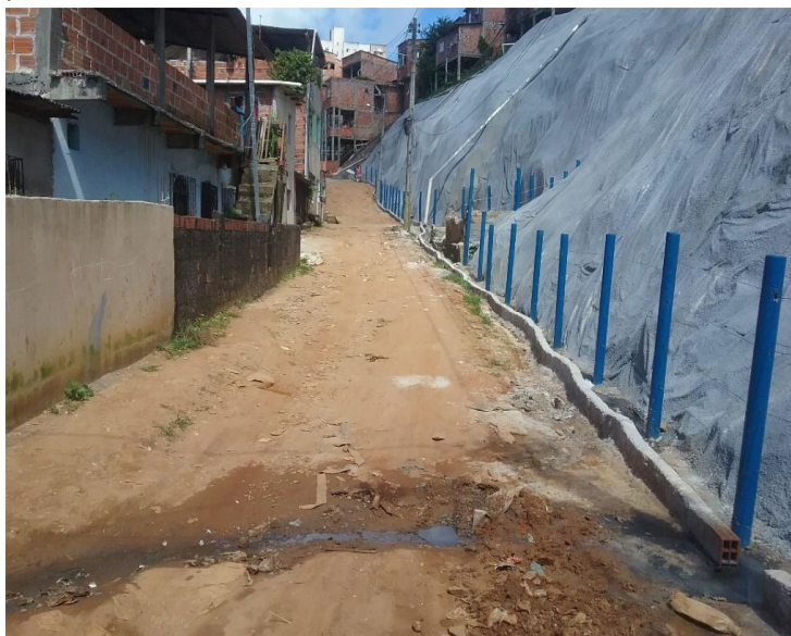
Foto 11 - Vista da Travessa Padre Ugo, com a geomanta aplicada à encosta. Fonte: PAE Padre Ugo 2018
