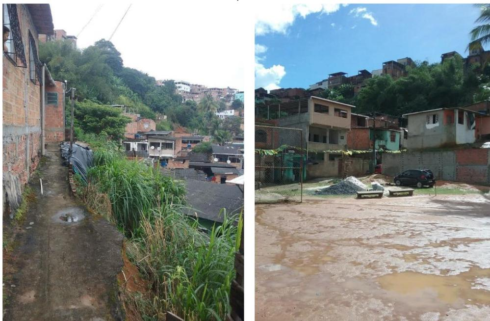
Foto 3 - Residências construídas no topo do talude com sinais de erosão (esc.). Retrato da amplitude da encosta (dir.). Fonte: PAE Beira Dique 2018
